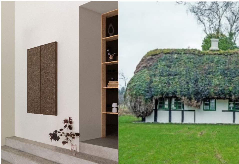
Figur 13. Anvendelser af ålegræs i byggeriet. De traditionelle tangtage på huse på Læsø (foto: Colourbox) og akustikpaneler af ålegræs fra Søuld (foto: Christian Møller Andersen).
