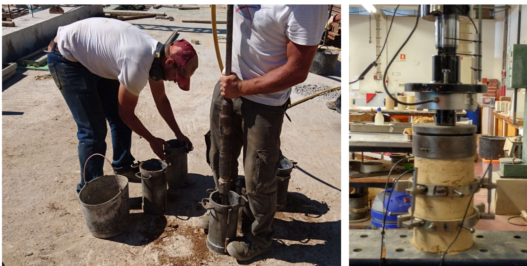
Fig. 3 – Controlo de qualidade através de ensaios de compressão.
