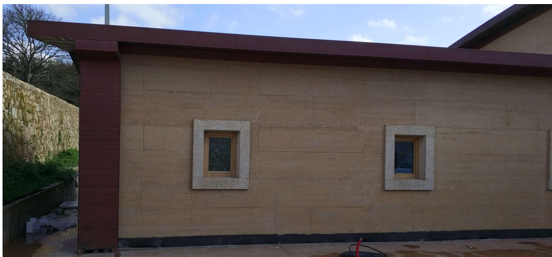
Fig. 2 – Aspeto de uma parede de taipa face à vista.
