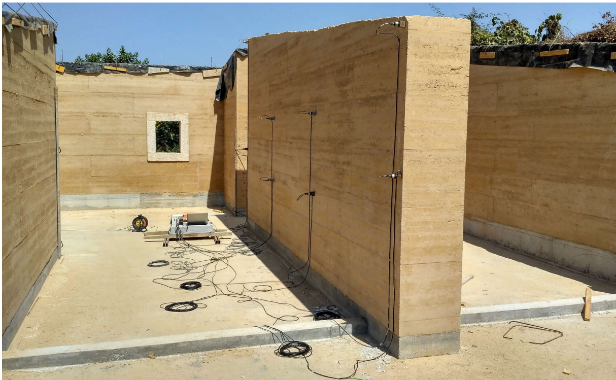
Fig. 4 – Ensaio de identificação dinâmica de uma parede de taipa.
