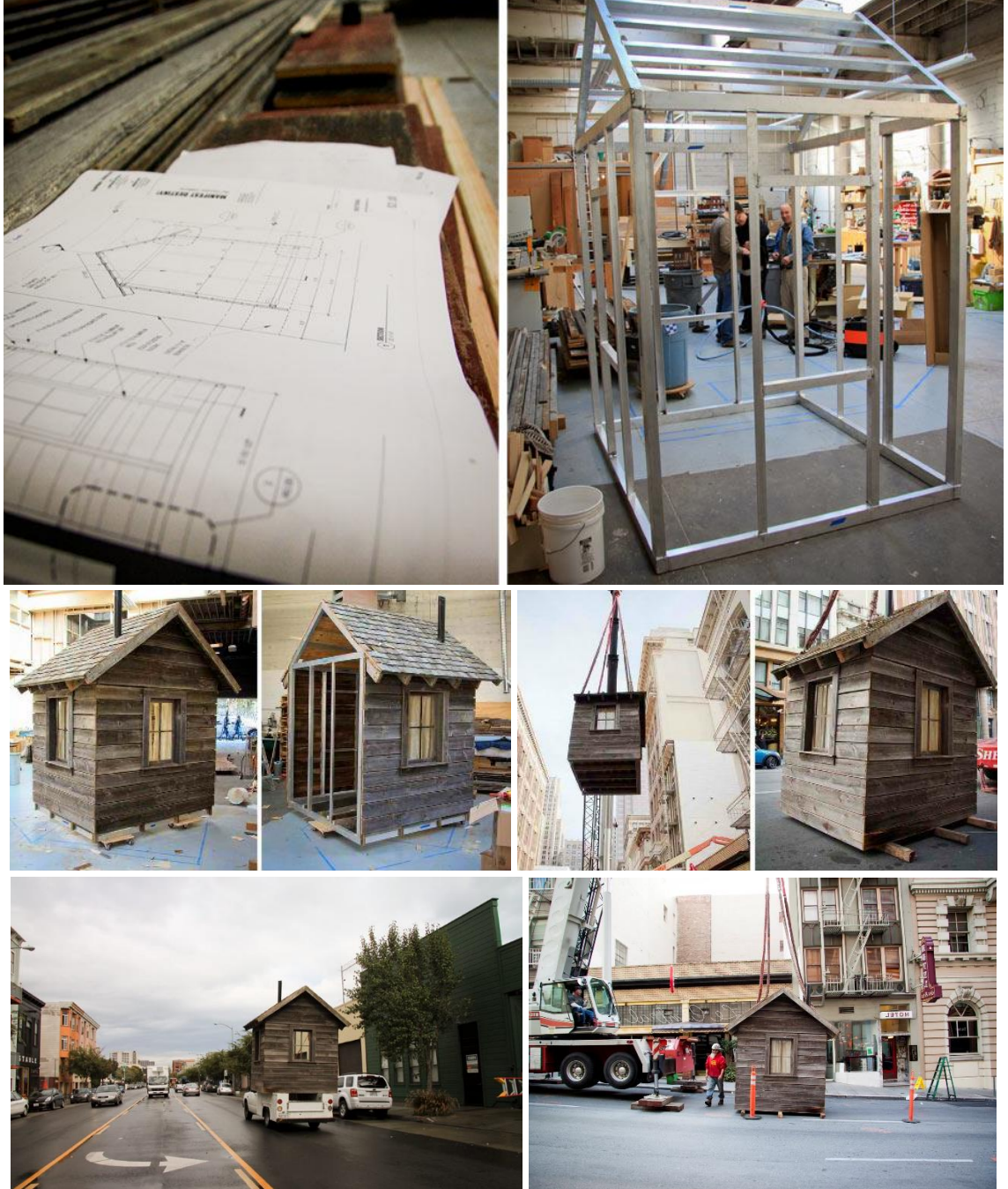
Şekil 4.44. Manifest Destiny'nin üretimi ve alana taşınma aşamaları (Dezeen, 2012a)
