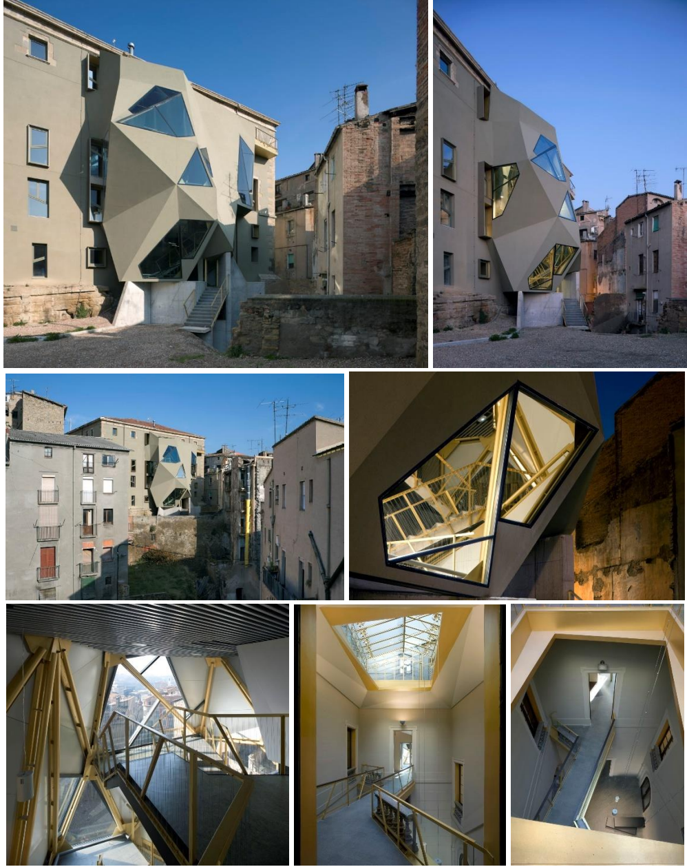
Şekil 4.19. Manresa City Hall'a ait fotoğraflar (ArchDaily, 2009a)
