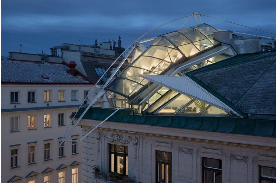
Şekil 4.59. Rooftop Office'e ait bir fotoğraf (Archidose, 2000)
