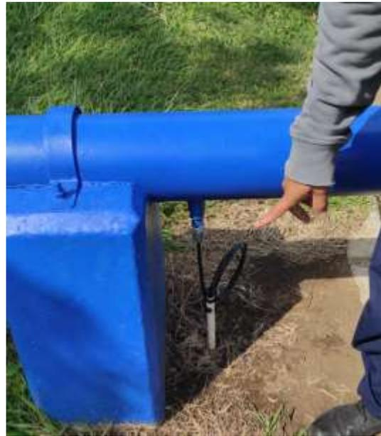
*IMAGEN 8 clorador del pozo inhabilitado*
