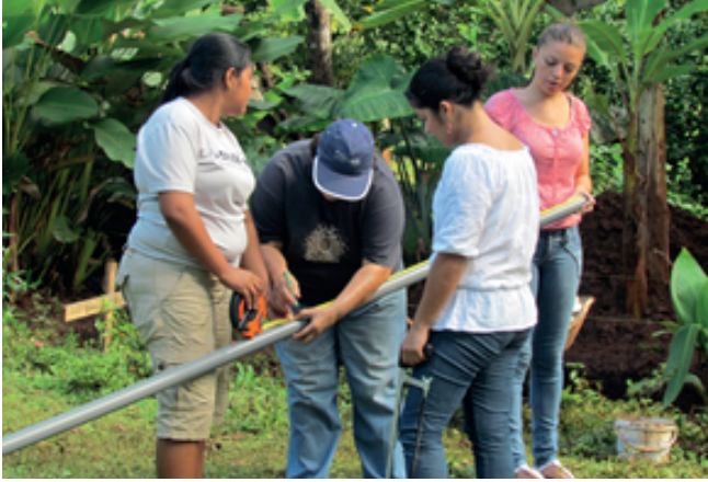
Figura 6 Preparación de la tubería.
