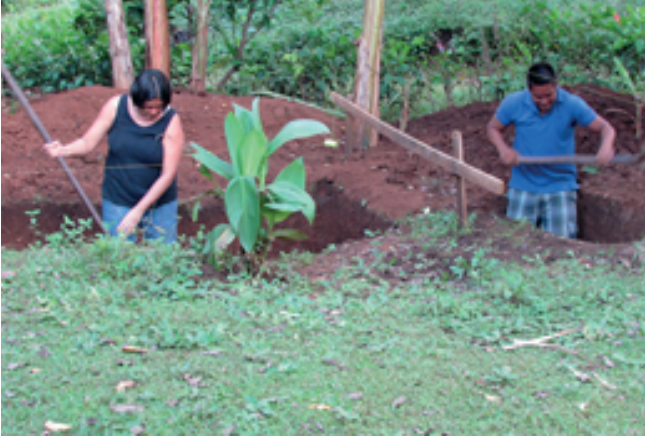
Figura 4 Zanjeado del terreno.
