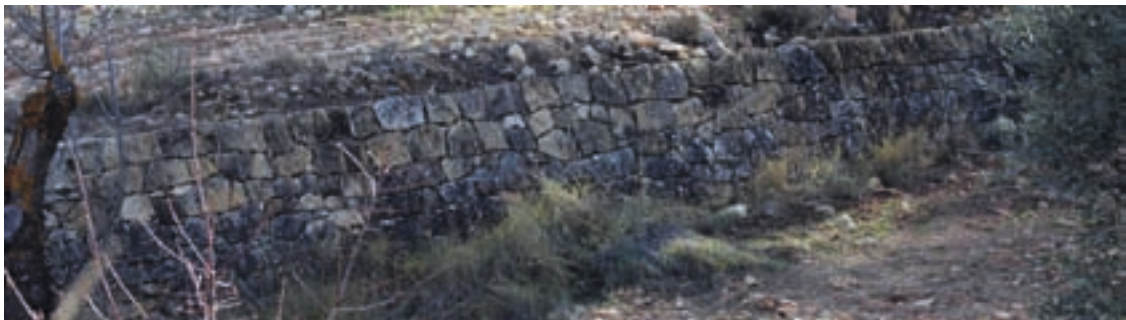
Fig. II-1.43. Bancal de aparejo semipoligonal de la casa de Villaplana en Navayol
