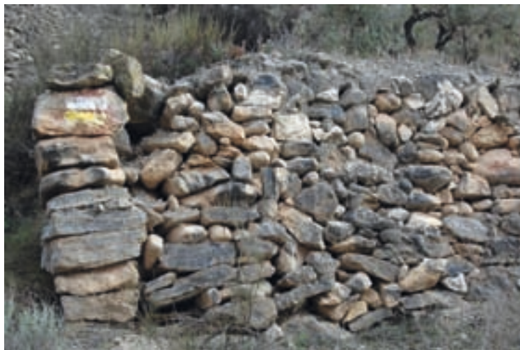
Fig. II-1.22. Muro de mampostería en seco realizado con lascas de yeso, junto a la Calera en la rambla de Puça
