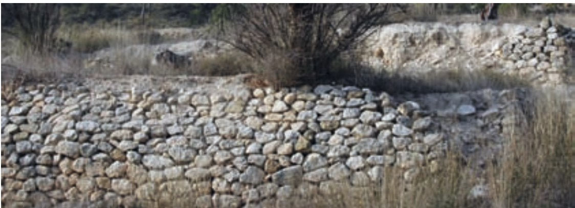
Fig. II-1.36. Muro de mampostería en seco con labrado del aparejo más cuidado. Aiguarrius
