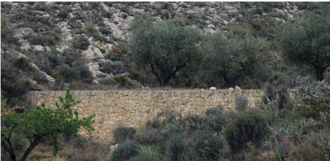
Fig. II-1.41. Estos bancales, gracias a su perfecto diseño, ejecución, y mantenimiento han resistido las crecidas de agua del barranco en la partida de Cotxinets
