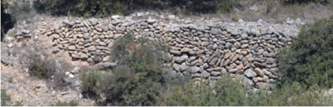
Fig. II-1.34. Piedras dispuestas de forma irregular y poco labradas. Carretera de Puça a Castalla
