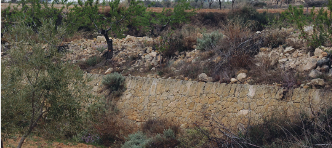
Fig. II-1.39. Bancales de Cotxinets de aparejo semipoligonal
