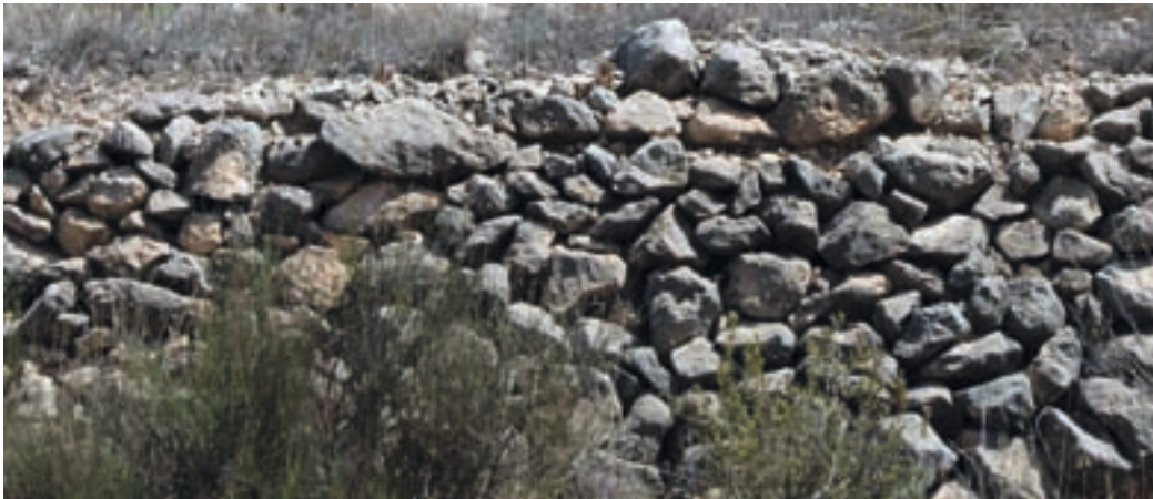
Fig. II-1.31. Detalle de aparejo irregular sin labrar y de tamaños variados. Carretera de Petrer a Castalla
