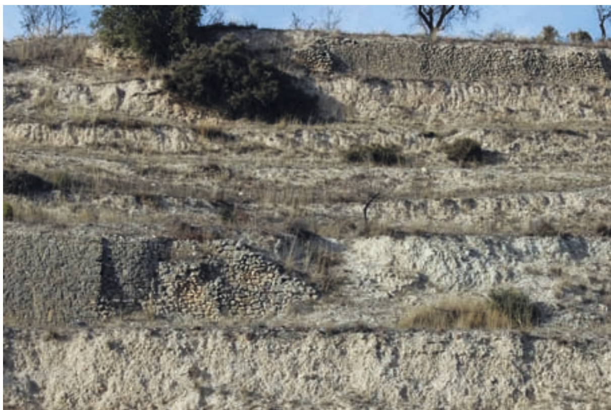
Fig. II-1.23. Importancia del tipo de aparejo en la conservación del muro del bancal. Casa de la Señora, a la derecha del molino de la Reixa
