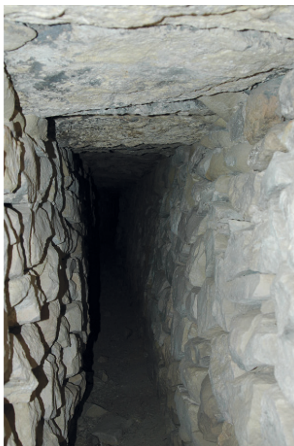
Figs. II-1.81 y 1.82. Casa de Monis. El agua procede del Salt de Canuto, pero únicamente se canaliza tras lluvias intensas
