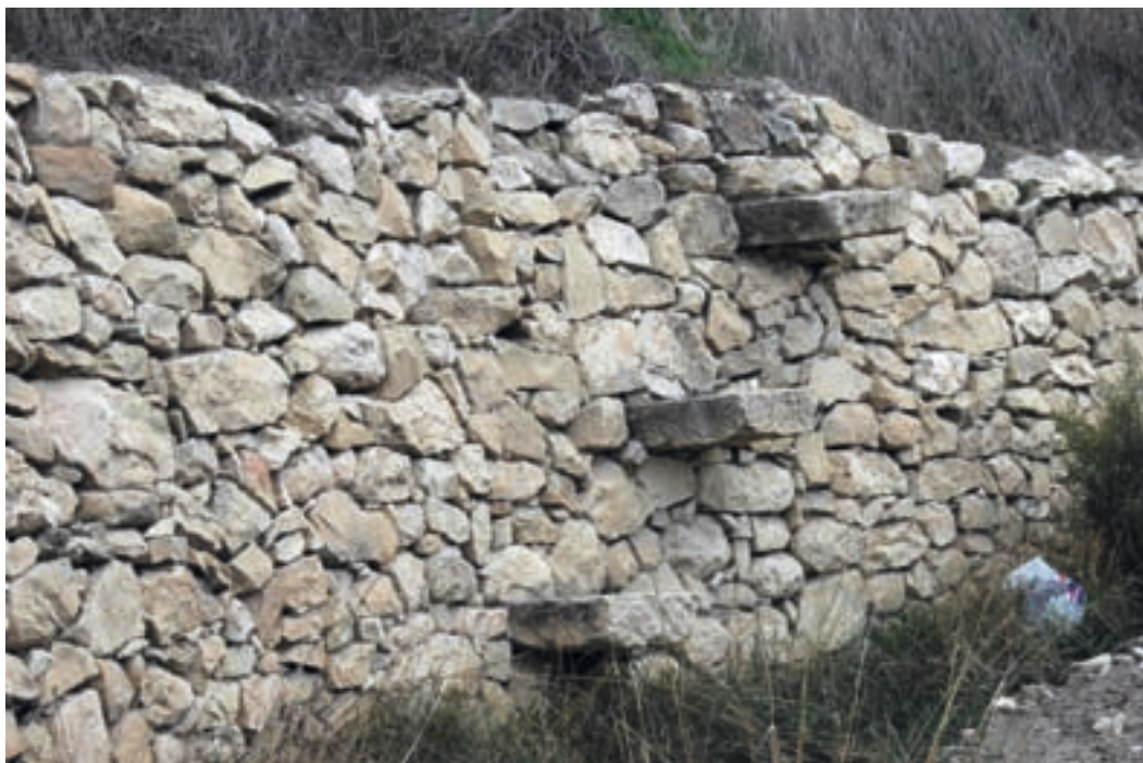
Fig. II-1.64. Escalera volada en la Administración
