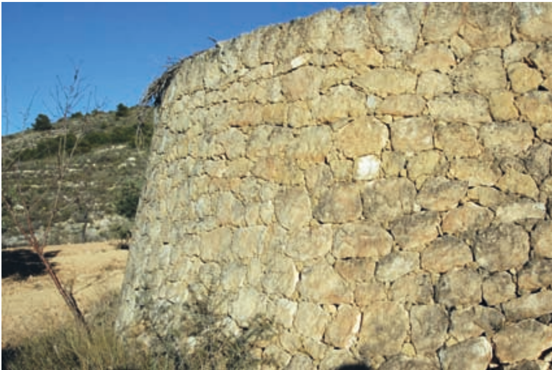
Fig. II-1.45. Detalle del bancal de la figura anterior. Para evitar la pérdida de agua, el espacio entre los sillares labrados se rellenó con piedras de pequeño tamaño
