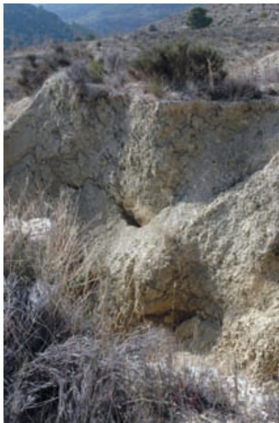
Fig. II-1.144. Erosión en terrenos margosos en el Palomaret (cases de Dalt)
