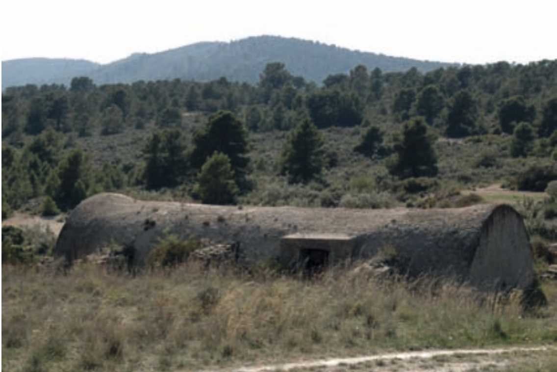
Figs. II-1.107 y 1.108. Balsas de decantación y cisterna del Esquinal
