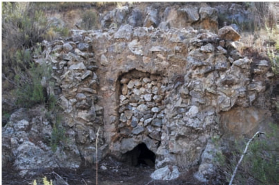
Figs. 3 y 4. Cantera de yesos del Keuper en Navayol. El horno para su explotación, en excelente estado de conservación, lo construyó don Luis Villaplana (1920-1930)
