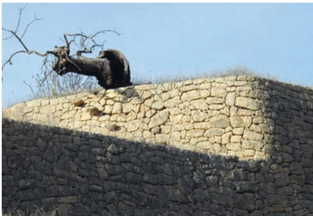
Fig. II-1.65. Pequeños peldaños para acceder al bancale superior, junto al molino de la Reixa, en Puça
