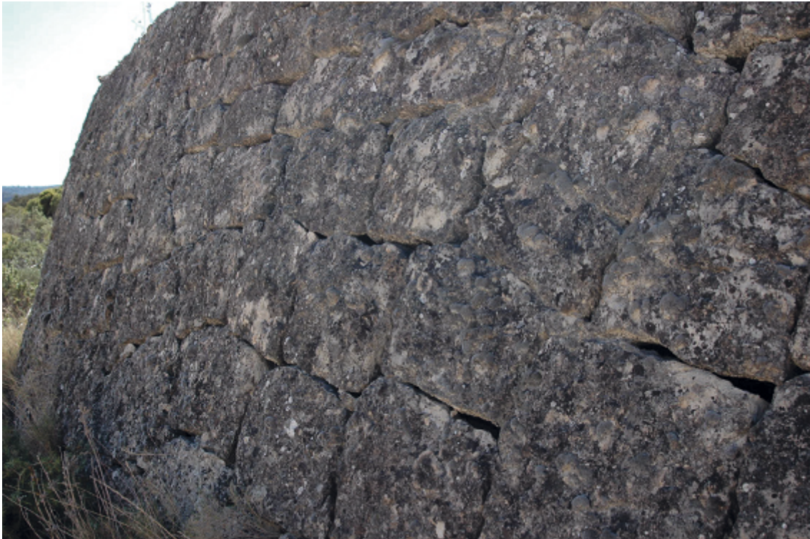
Fig. II-1.46. Bancal de perfecto trazado, de aparejo poligonal en Cotxinets
