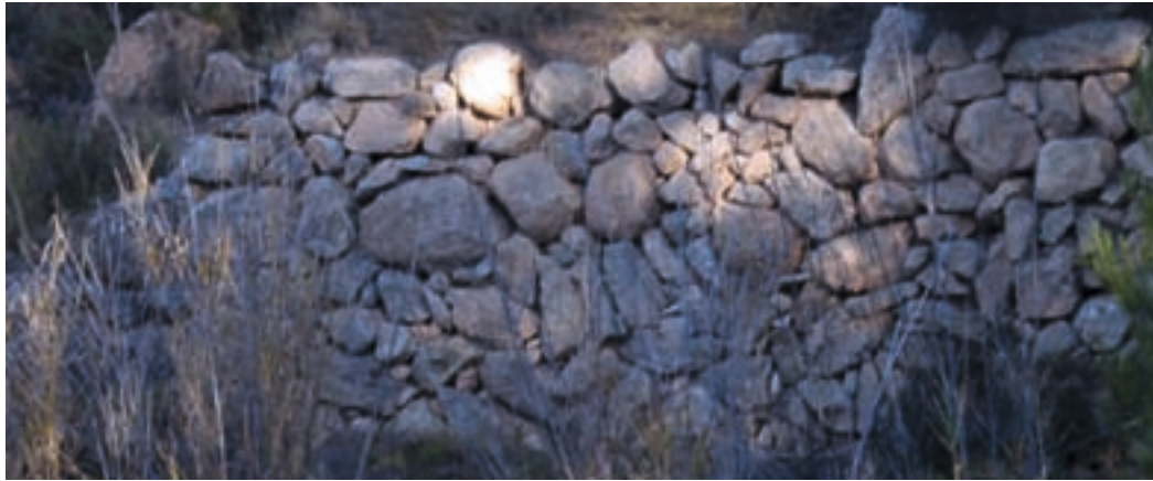
Fig. II-1.27. Disposición irregular de las piedras sin labrar. Casa de Villaplana en Navayol
