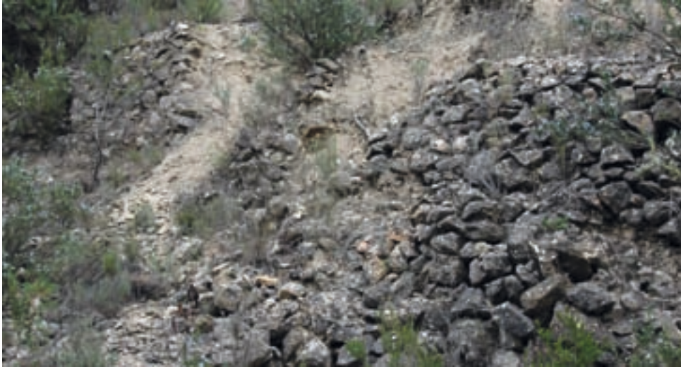
Fig. II-1.30. Este tipo de aparejo irregular se componía en general de una sola hilera de piedras, que requería de continuas reparaciones tras episodios de lluvias torrenciales. Ejemplo de l'Almadrava
