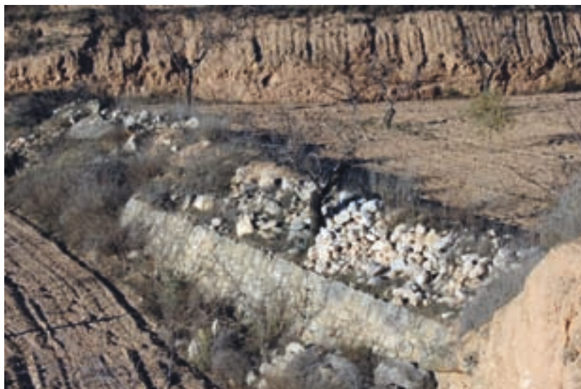
Fig. II-1.50. Bancal construido en el cauce del barranco, que se ha sobreelevado con piedras amontonadas. Cotxinets
