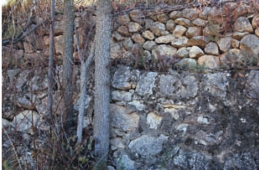
Fig. II-1.37. Aparejo irregular muy labrado en el tramo inferior de un bancal de la casa de Villaplana en Navayol
