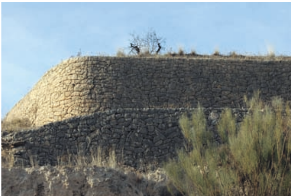
Fig. II-1.48. Bancal de aparejo poligonal junto al molino de la Reixa, en Puça
