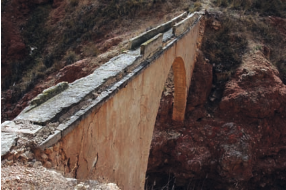
Fig. II-1.100. Acueducto del marquesat de Noguera, construido en el año 1901
