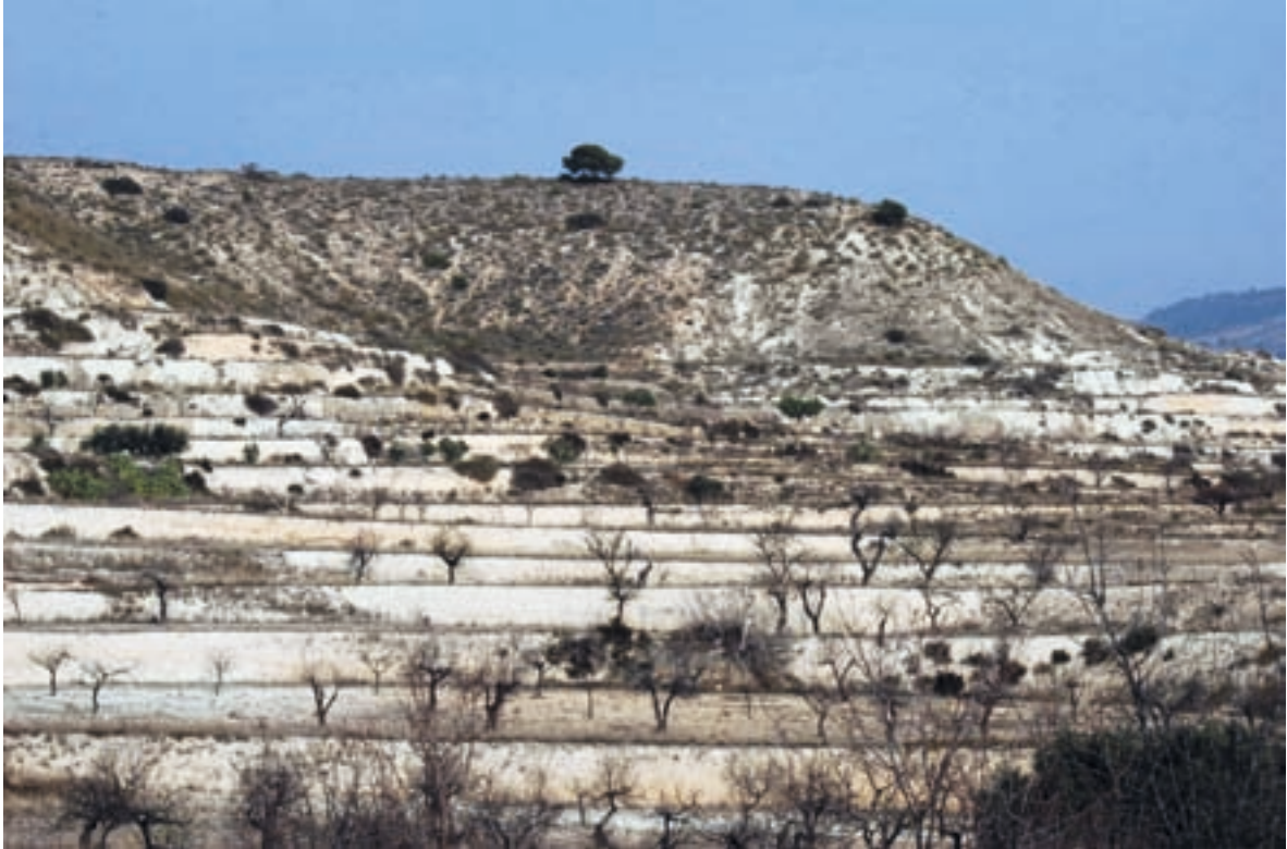
Fig. II-1.58. Pérdida de piedras de los bancales, tras la ausencia de prácticas de mantenimiento, debido a que consistían únicamente de una hilera de piedras. Les Pedreres Altes
