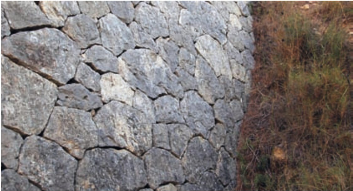
Fig. II-1.42. Casa de Villaplana en Navayol, bancal construido entre 1920 y 1930, con un encaje perfecto entre las piedras
