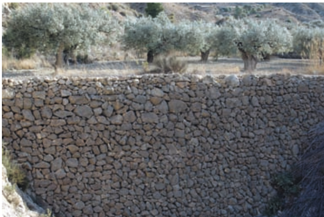
Fig. II-1.117. Parat del Cid, de 8 metros de altura, construido en 1877
