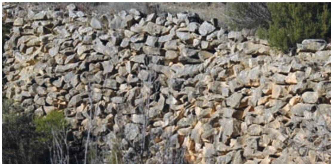
Fig. II-1.28. Aparejo sin labrar de caliza en el pla de Manel
