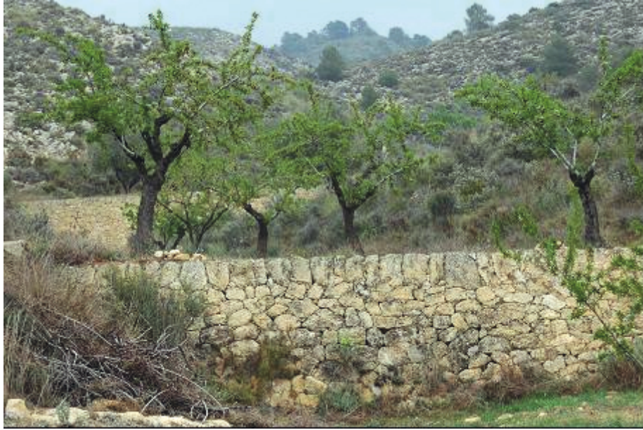
Fig. II-1.62. Bancal con rasante, de perfecta factura. Cotxinets
