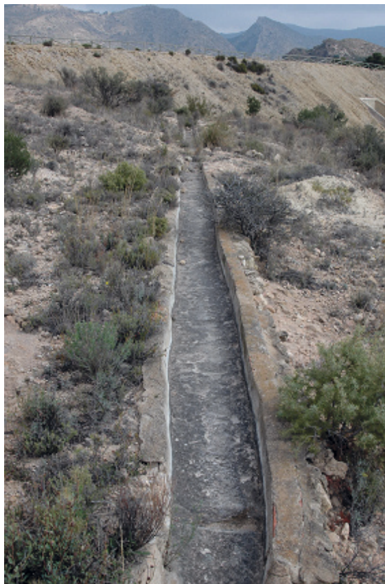
Fig. II-1.95. Acequia que conducía el agua a la balsa del Palomaret
