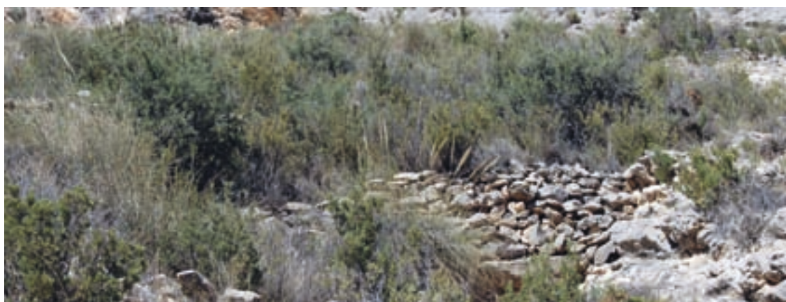
Fig. II-1.29. En el barranco de la Petiosa se construyeron los bancales con aparejos irregulares sin labrar, y sin ningún tipo de coronamiento
