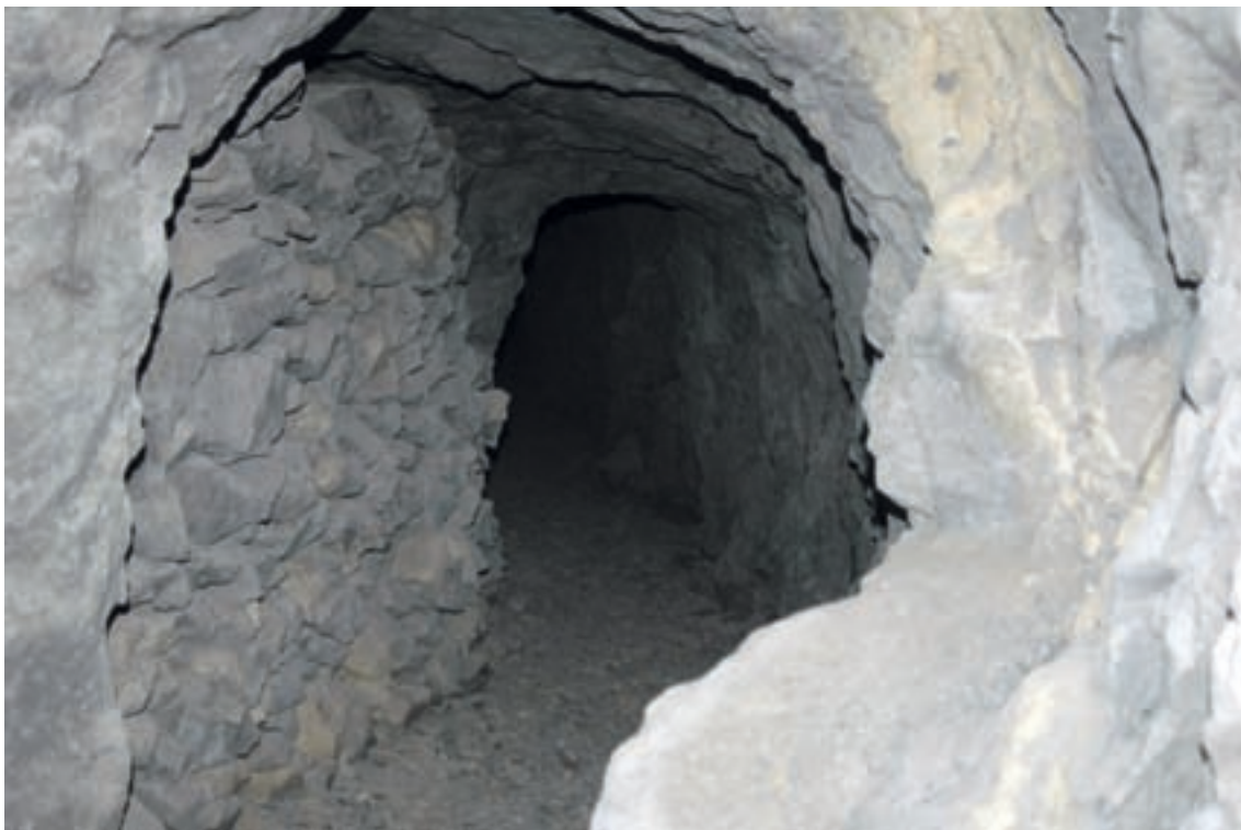
Figs. II-1.75 y 1.76. Pozo de ventilación y últimos tramos construidos de la mina de Puça
