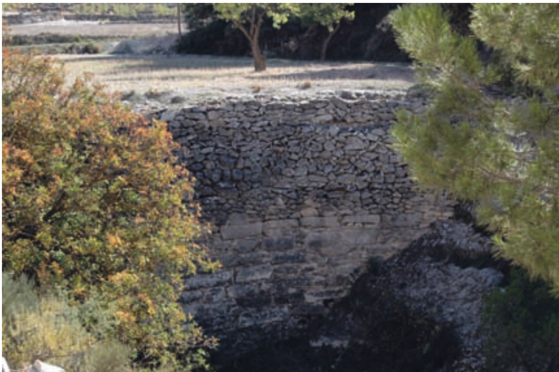
Fig. II-1.47. El tramo inferior del parat del Catxuli está construido con sillares rectangulares, de piedra caliza, sin salientes, que ha resistido las avenidas del barranco
