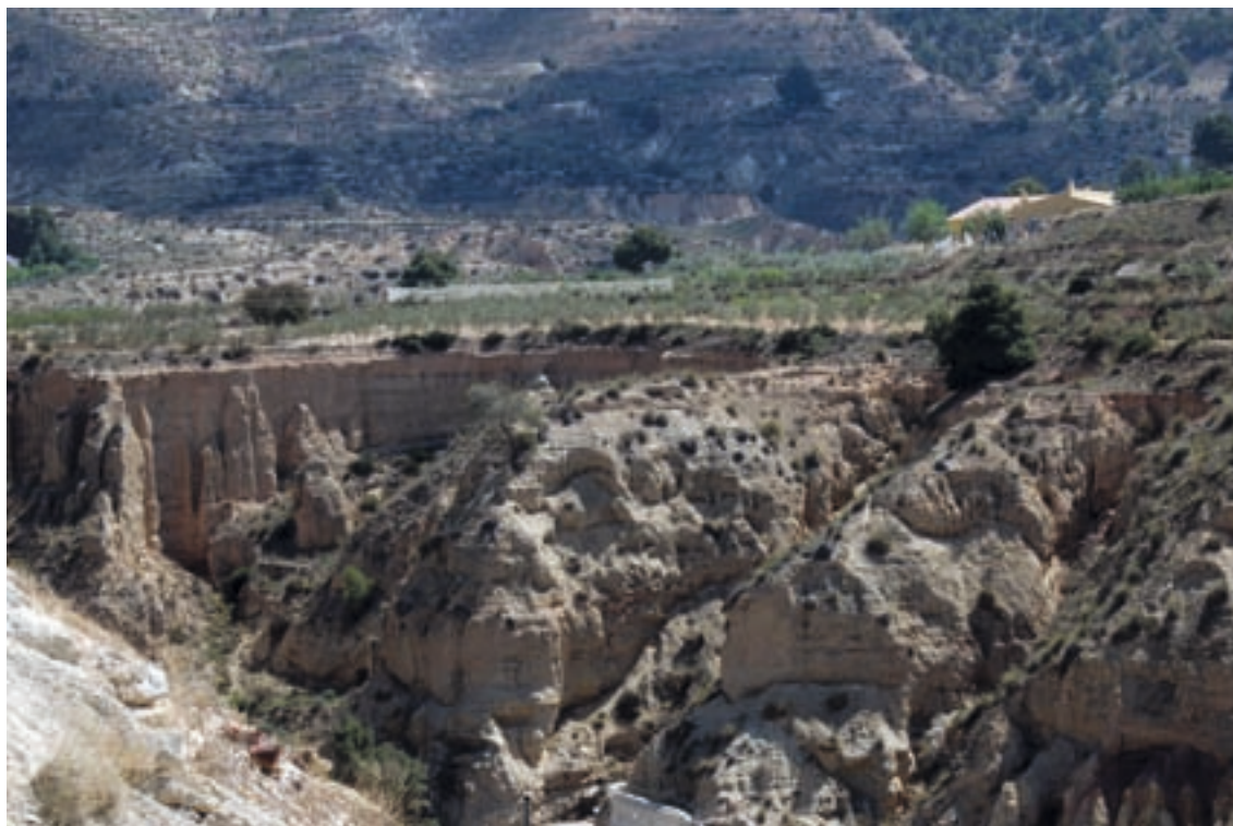
Fig. II-1.136. Bancales que han quedado colgados, debido a la erosión de sus paredes, sobre la rambla de Puça
