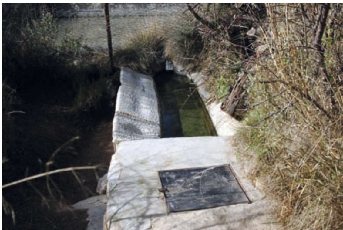
Fig. II-1.124. Lavadero de la balsa de Caprala, construida en 1766
