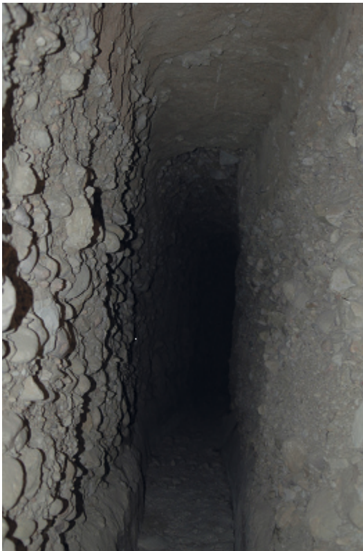
Figs. II-1.77, 1.78, 1.79 y 1.80. Mina de la Bienvenida. El comienzo de la mina no presenta ningún tipo de revestimiento, el tramo intermedio está abovedado y revestido el techo de losas y los muros con mampostería en seco. El tramo final está de nuevo sin revestir. En la foto de abajo a la derecha se aprecia la canalización del agua
