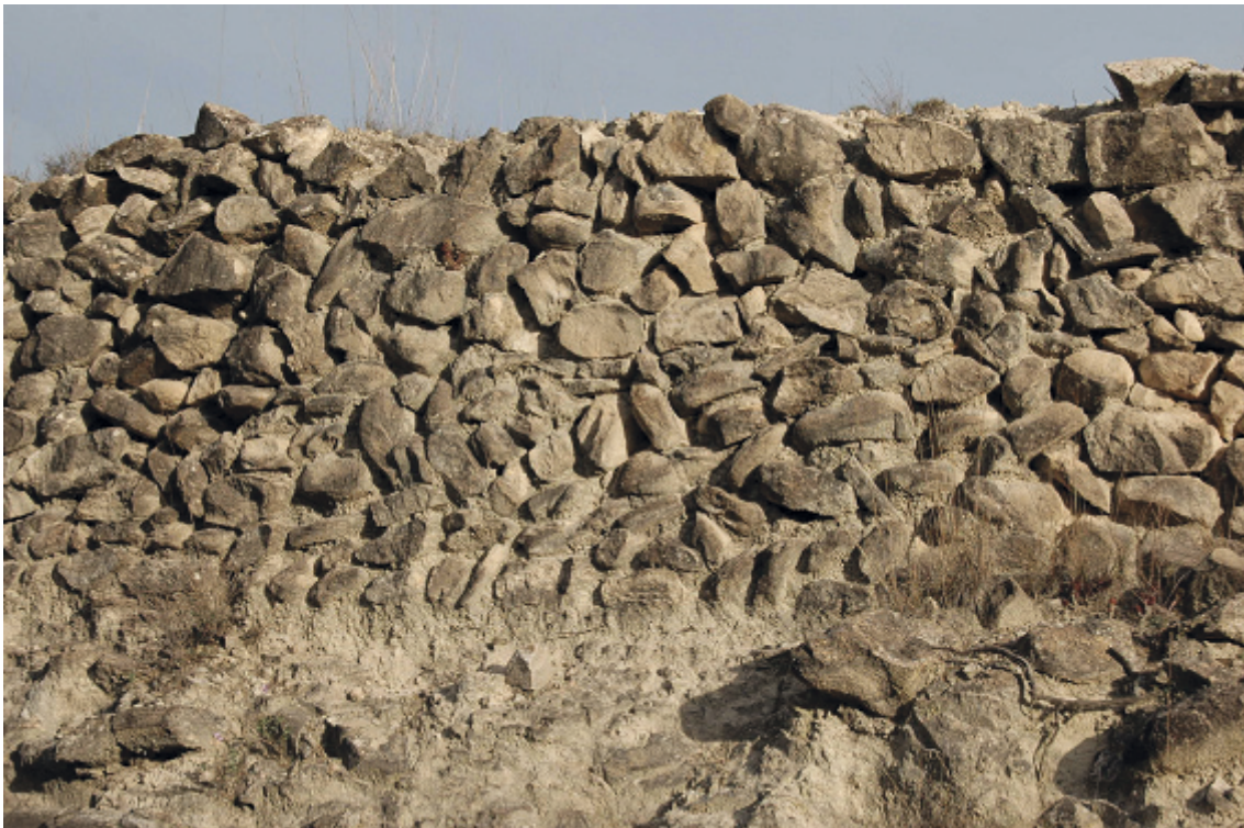
Fig. II-1.33. Aparejo irregular poco labrado pero muy cementado y efectivo para retener el suelo. La Foia Falsa
