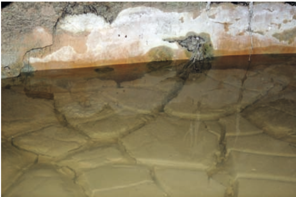
Figs. II-1.114, 1.115 y 1.116. Conducción del agua de escorrentía y pequeña cisterna para recoger el agua. Racó i Coloma, en el Xocolate. Partida en cultivo con anterioridad a 1841
