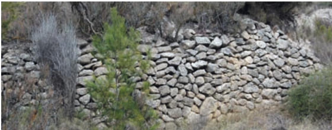
Fig. II-1.18. Muro de mampostería de piedra caliza, en la Administración
