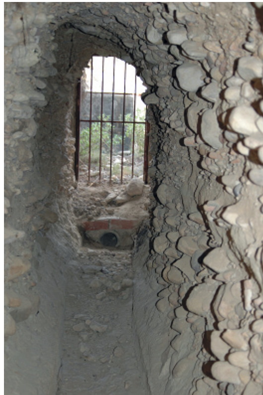
Figs. II-1.77, 1.78, 1.79 y 1.80. Mina de la Bienvenida. El comienzo de la mina no presenta ningún tipo de revestimiento, el tramo intermedio está abovedado y revestido el techo de losas y los muros con mampostería en seco. El tramo final está de nuevo sin revestir. En la foto de abajo a la derecha se aprecia la canalización del agua
