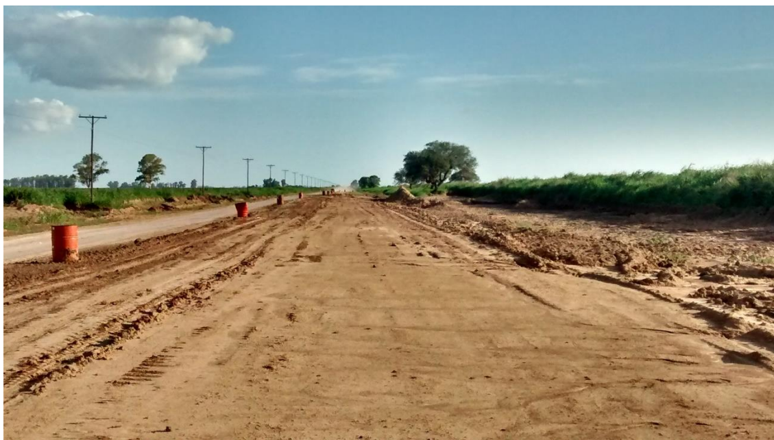
Figura 2-2: Limpieza de Terreno
