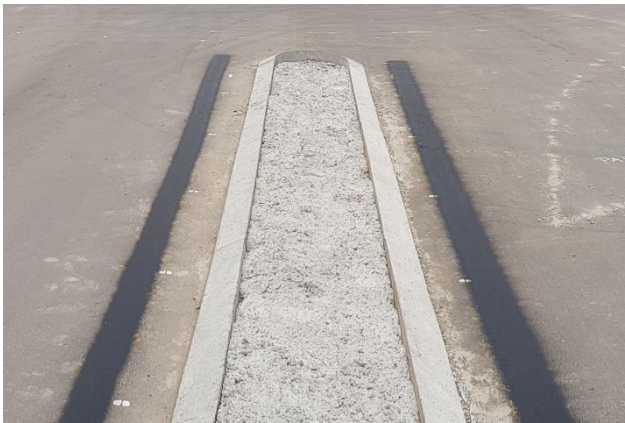
Figura 12-1: Riego de liga para la demarcación horizontal
