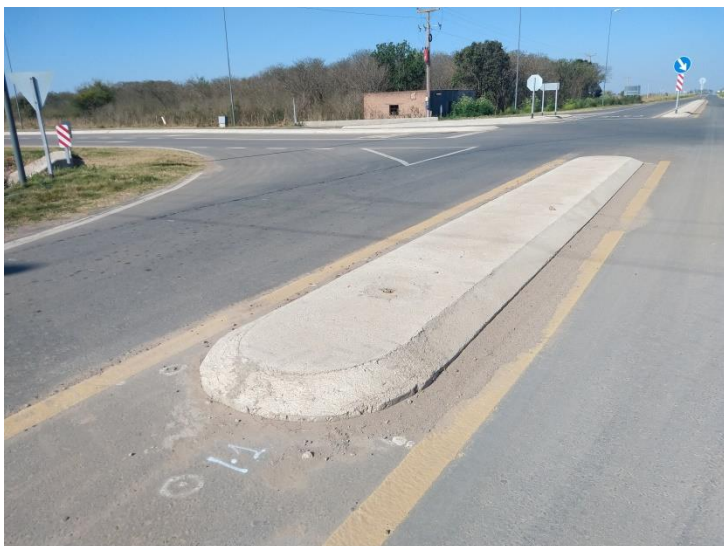
Figura 8-6: Isleta de intersección, cordón montable y relleno
