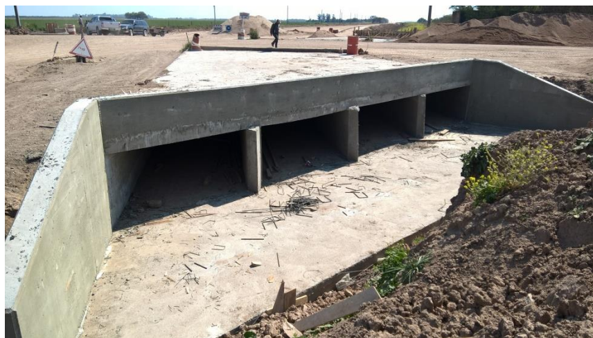
Figura 8-3: Prolongación de alcantarilla terminada
