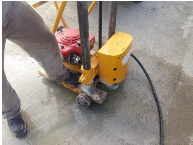
Figura 8-19: Extracción de testigos en losas de hormigón
