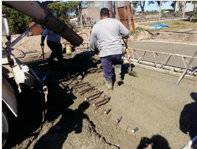
Figura 8-12: Colocación de Hormigón elaborado, vibrado con regla vibratoria y vibrador portátil de inmersión
