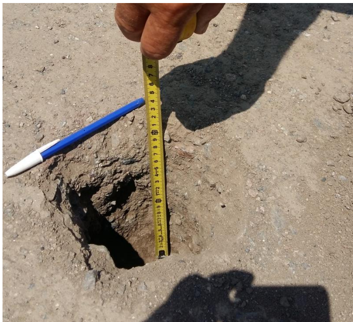
Figura 5-3: Control de Densidad de Obra y Espesores
