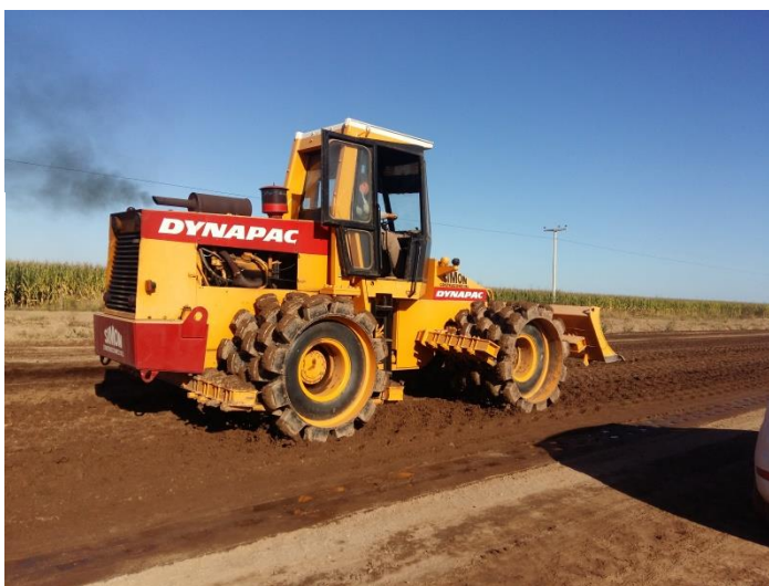
Figura 3-5: Compactación de una Capa de Terraplén
