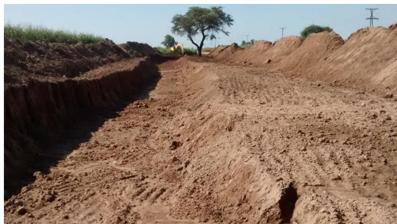
Figura 3-3: Conformación de Cunetas y Acopio de Suelos para Terraplén
