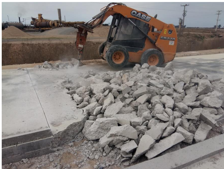
Figura 8-17: Demolición de losa del pavimento por presencia de fisuras
