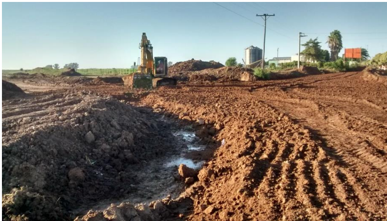
Figura 3-2: Obras Provisorias Para Esguimiento de Excedentes Pluviales
