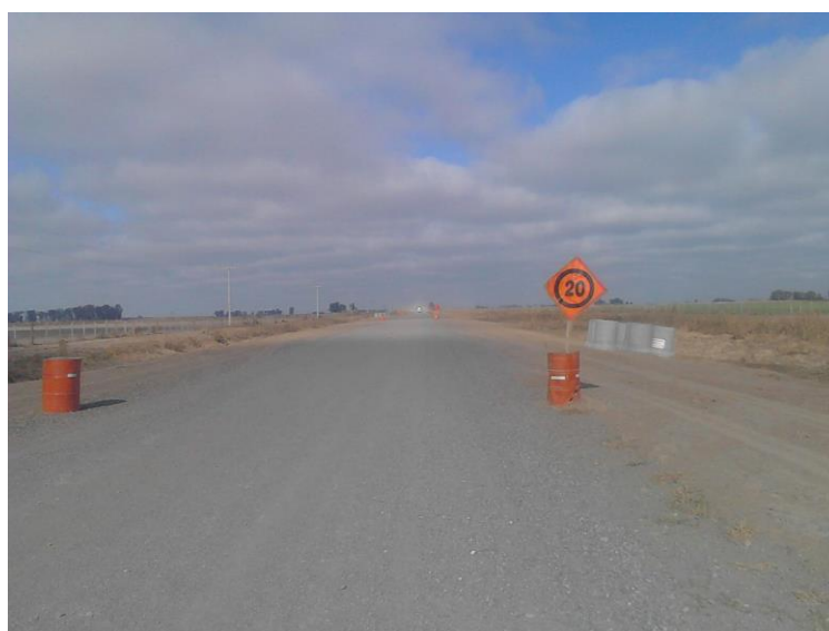
Figura 5-2: Base granular finalizada, lista para imprimación
