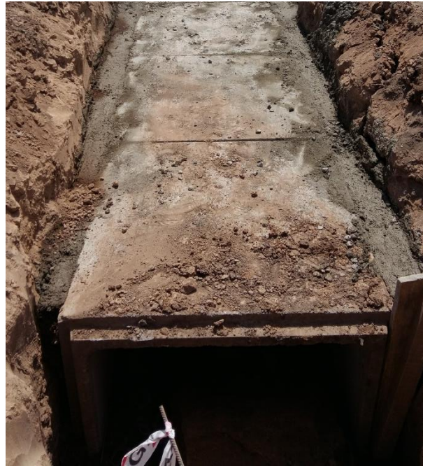
Figura 7-4: Colocación de módulos y relleno de interface
