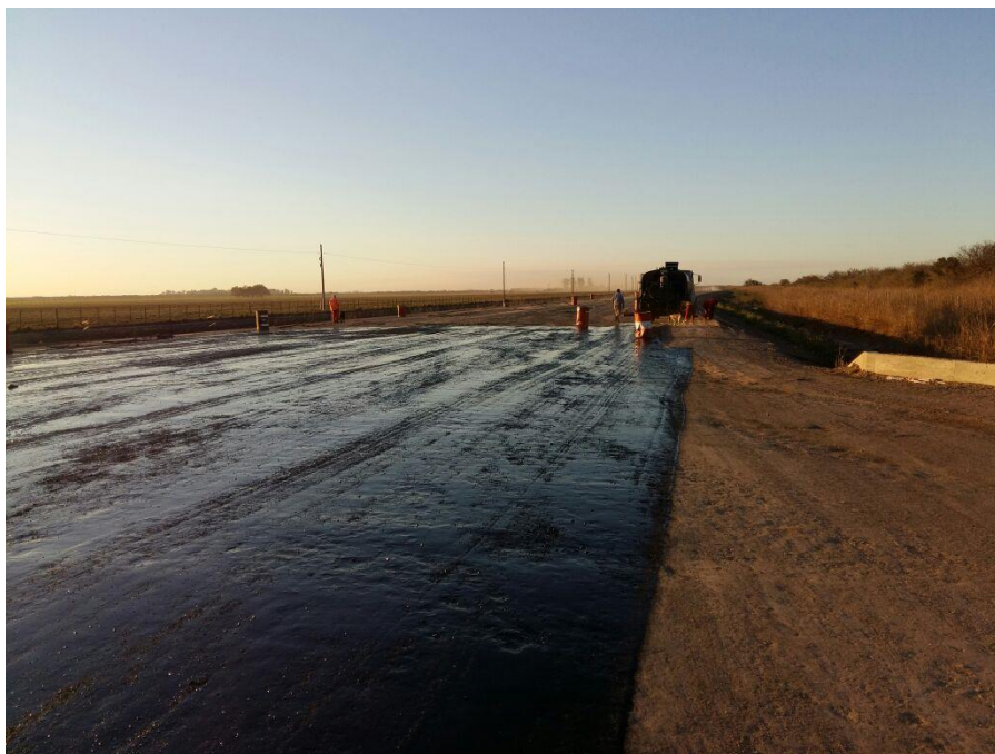
Figura 9-3: Superficie de base granular recientemente imprimada
