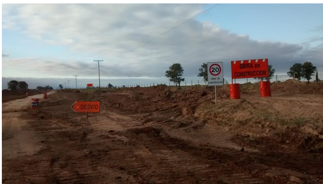
Figura 3-1: Ensanche Núcleo de Terraplén con Señalización de Obra
