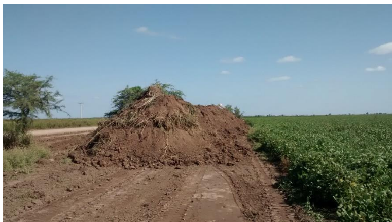
Figura 3-4: Extracción y Acopio de Material Vegetal
