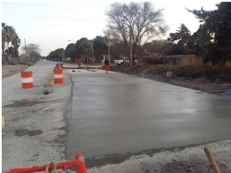
Figura 8-13: Avance de la terminación superficial luego del vertido y vibrado del Hormigón
