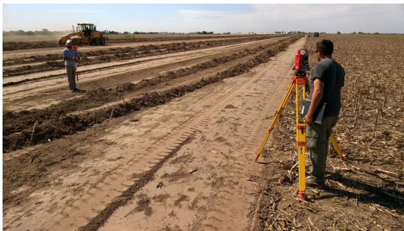
Figura 3-6: Relevamiento Altimétrico con Estación Total, una vez efectuada la limpieza
