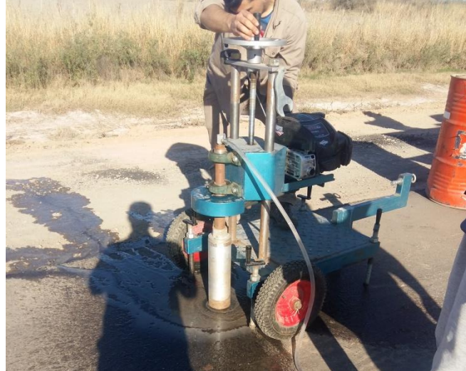
Figura 10-10: Extracción de testigos para la determinación del espeso y densidad de carpeta
