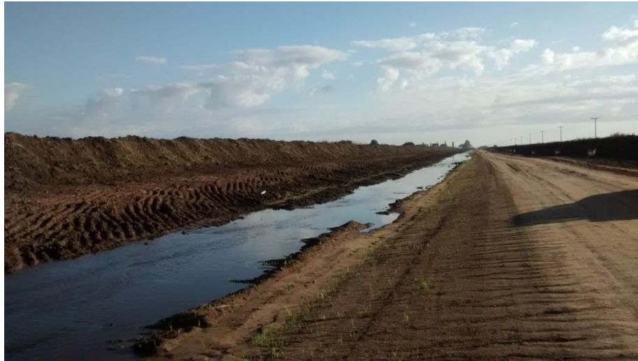
Figura 1-7: Escurrimiento Superficial Durante la Construcción
