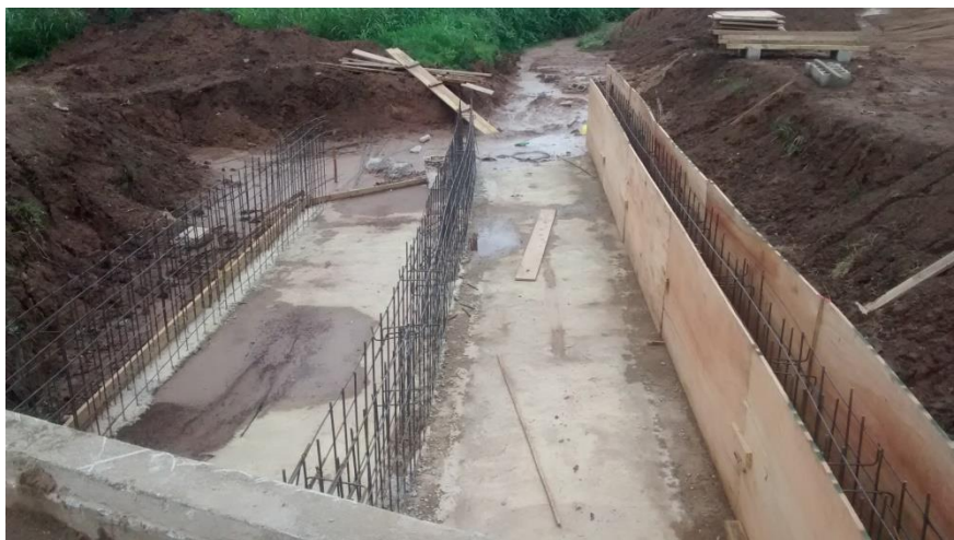
Figura 8-2: Alcantarilla a prolongar, en el cruce al acceso a Toro Pujio
