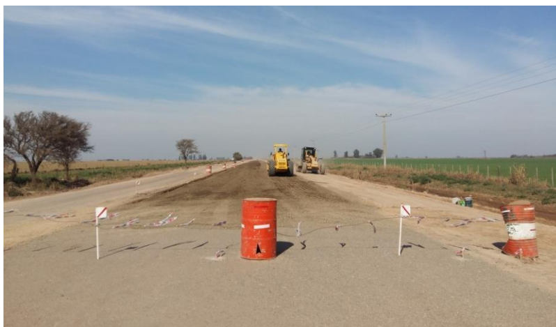
Figura 5-1: Compactación de Base Granular
