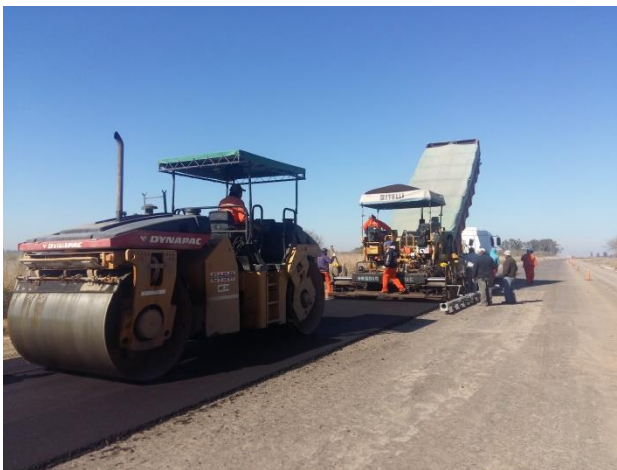
Figura 10-7: Aplanadora de rodillo vibrante
