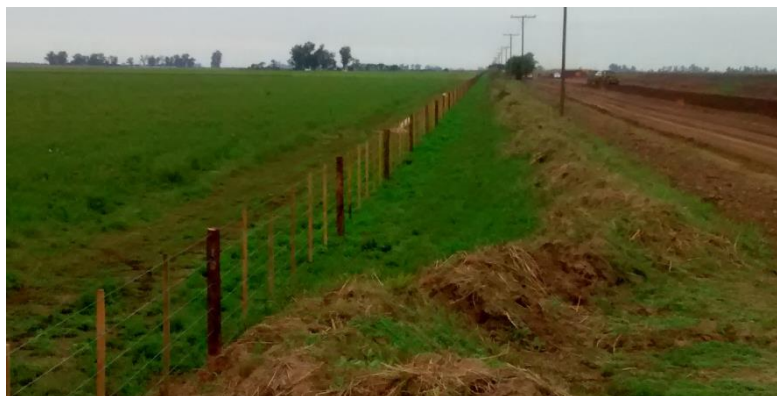
Figura 2-3: Ejecución de Nuevos Alambrados
