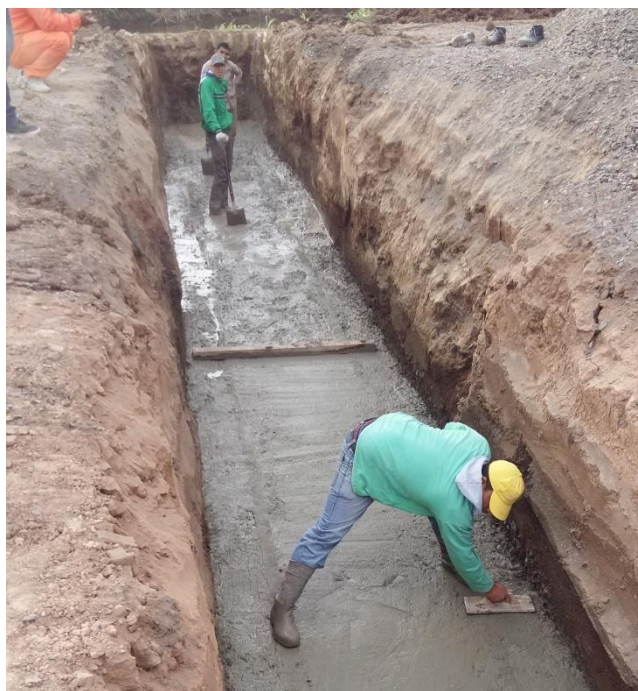
Figura 7-3: Preparación de la base de asiento de los módulos prefabricados con Hormigón H8
