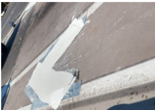
Figura 12-2: Cebreado por extrusión
