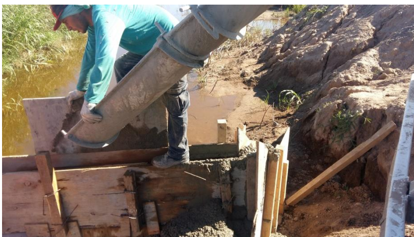
Figura 8-4: Hormigonado de cabezales de alcantarillas longitudinales
