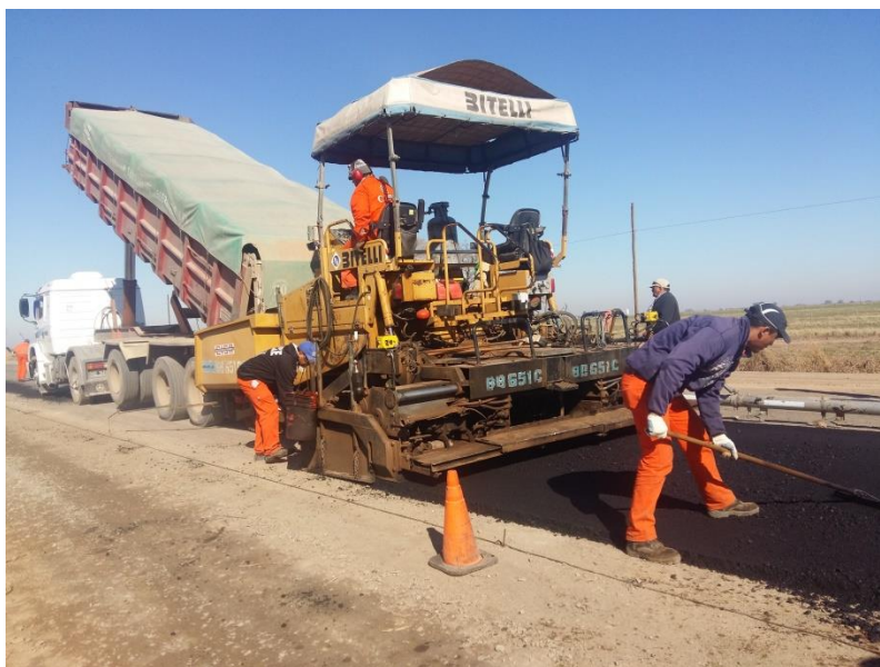
Figura 10-6: Batea transportadora de mezcla asfáltica y avance de terminadora
