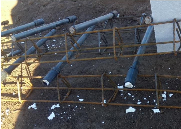
Figura 8-14: Pasadores de acero liso para juntas transversales, con cama porta pasadores para su correcta colocación
