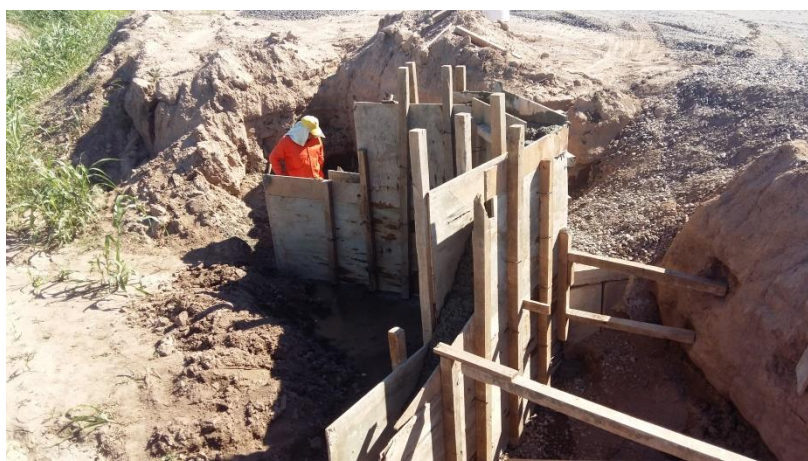
Figura 8-5: Desencofrado de cabezales de alcantarillas longitudinales
