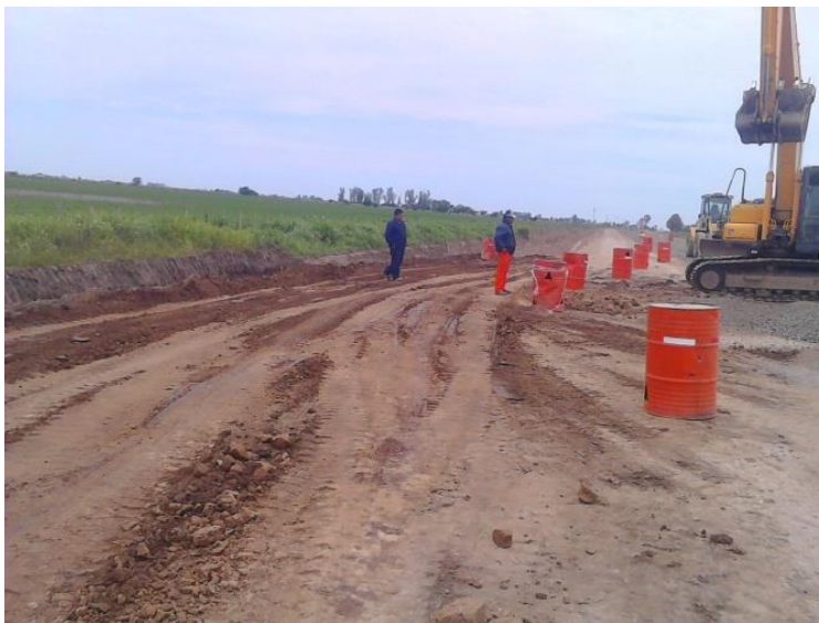
Figura 7-2: Ensanche de banquetas, señalización de obra, inicio de excavación
