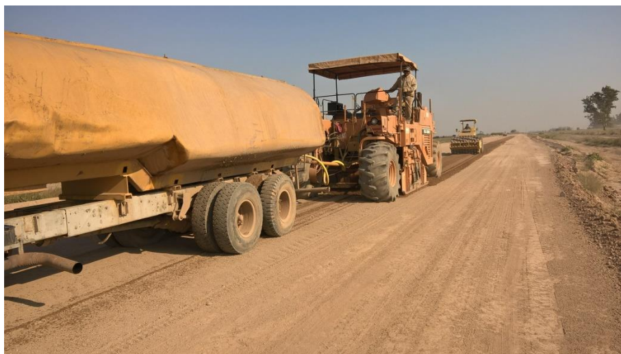
Figura 4-3: Avance del mezclado, humectación y compactación de la sub base
