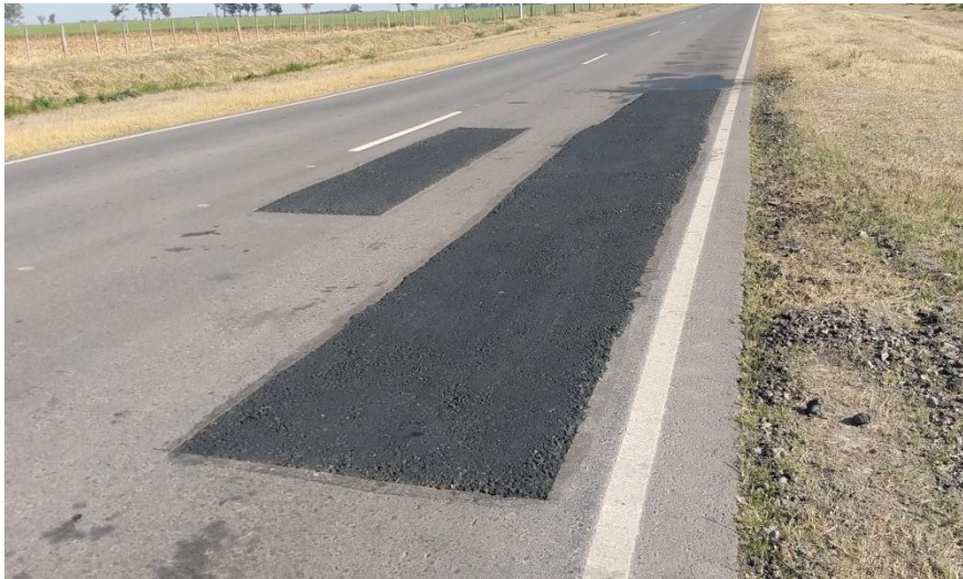
Figura 14-1: Reemplazo de carpeta de rodamiento durante el período de conservación
