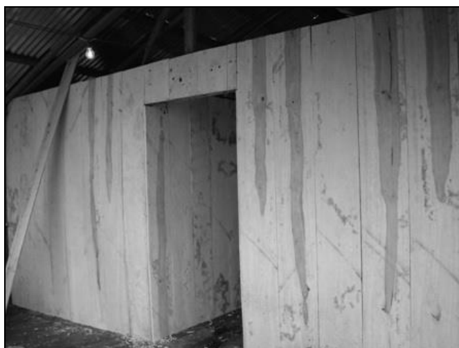
FIGURA 5 - Detalhe de uma casa de madeira com tábuas de assacu na Comunidade São José.
