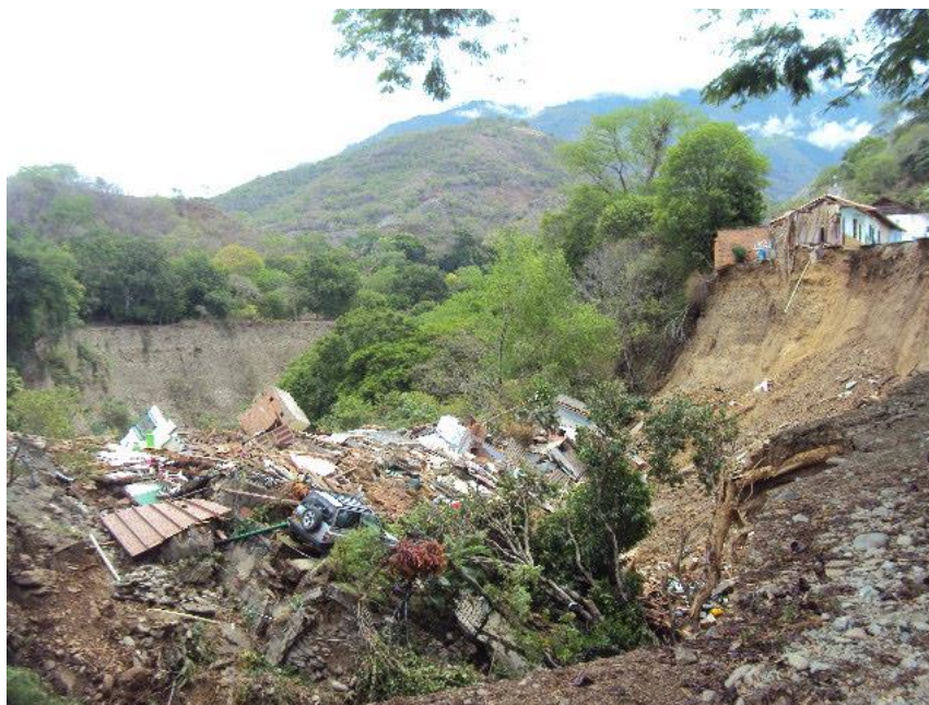
Figura 2. Deslizamiento ocurrido en la cabecera municipal de Olaya. Se puede observar el desnivel y el elevado ángulo de la ladera
