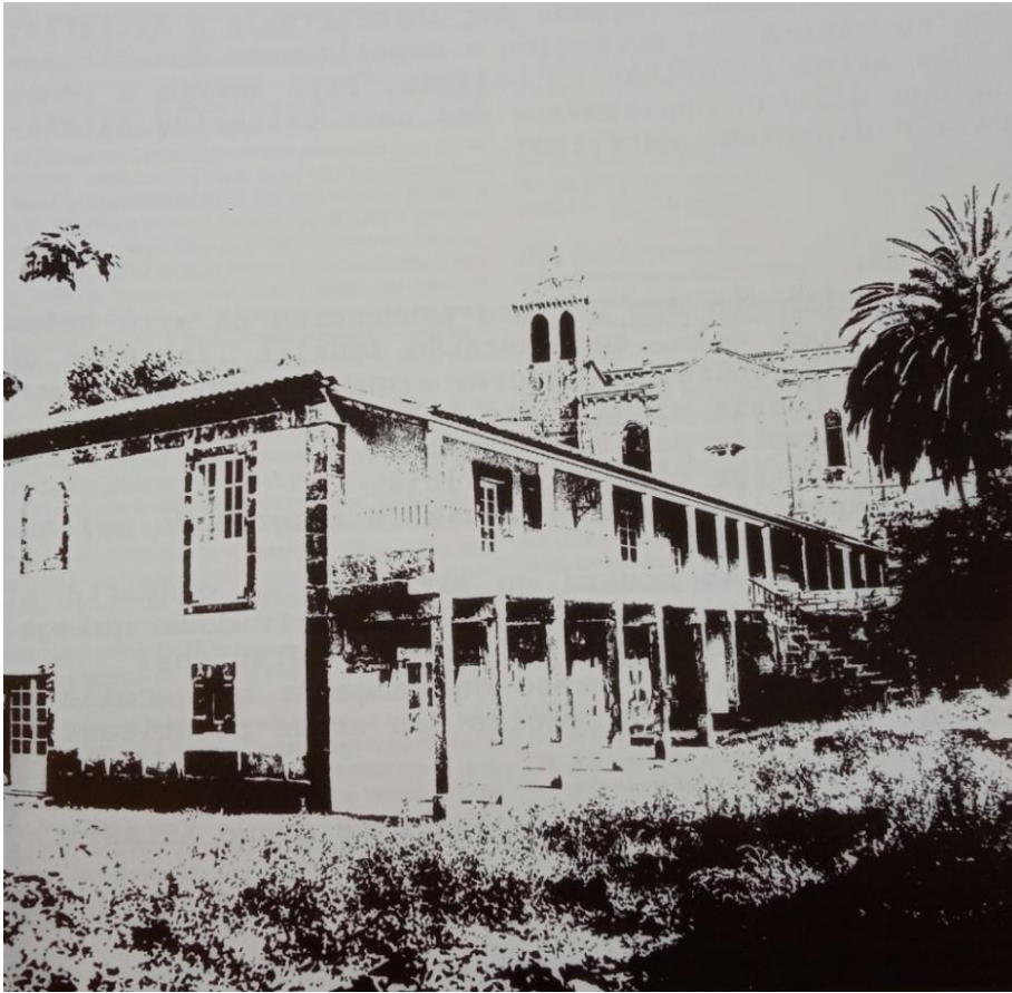
Fig. 4. Fotografía del antiguo Hospital del Santo Espíritu en Baiona, en el momento de la restauración para convertirlo en la nueva Casa de la Cultura.
