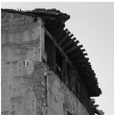
fig. 05 y 06 Fotografías del edificio Detalles del alero. Febrero 2019
