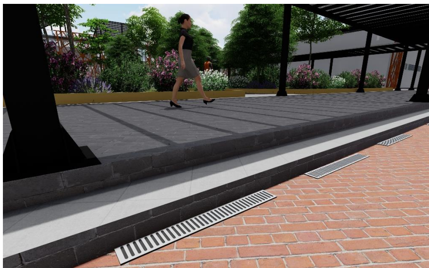
Figura 44: Sistema de canaletas en patio central
