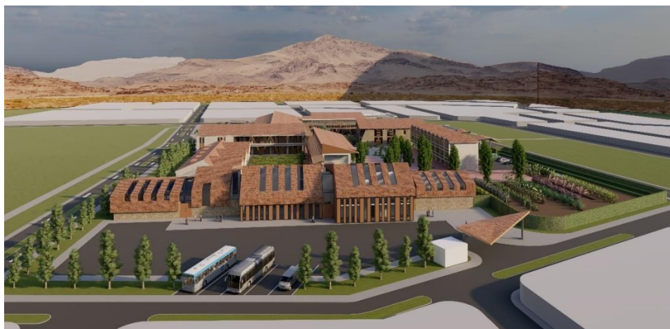
Gráfico 251: Vista fachada oeste Planta Piloto Textil
