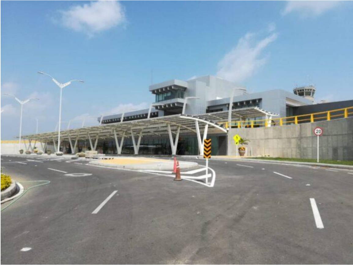
Imagen 2: Remodelación Aeropuerto Ernesto Cortissoz. (La Libertad, 2020)
