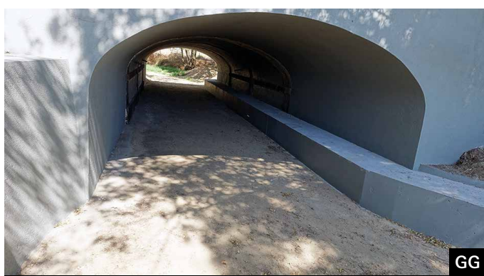
Visualização da integração do passadiço no terreno seco encaminhando os animais para o terreno adjacente numa das PH intervencionadas.
