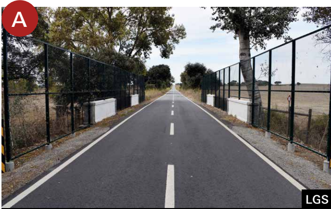
Exemplos de barreiras em rede para elevação do voo instalados durante o projeto: (A) na EM 529; e (B) na EN 114.
