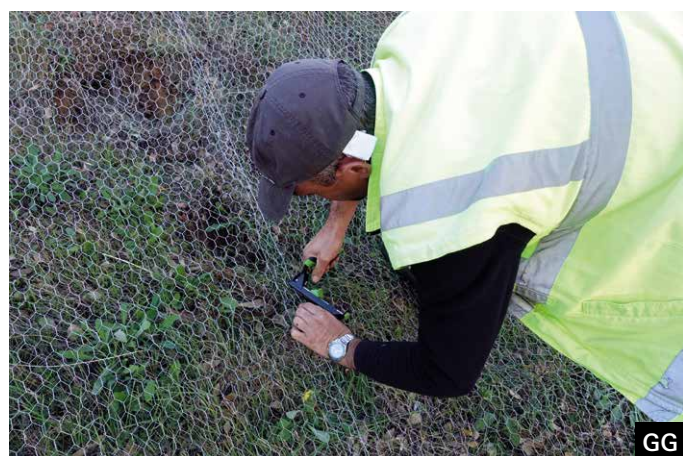
Colocação de rede dissuasora de coelhos nos taludes da EN4, no distrito de Évora.
