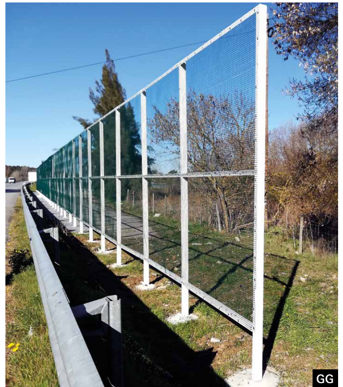
Exemplos de barreiras em rede para elevação do voo instalados durante o projeto: (A) na EM 529; e (B) na EN 114.
