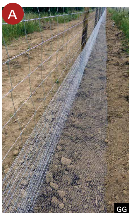
Instalação da rede em "L" nas vedações do IP2, no âmbito do projeto LIFE LINES: (A) colocação da rede em "L" junto à vedação e (B) recobrimento com terra e compactação, e (C) aspeto final da rede em "L".
