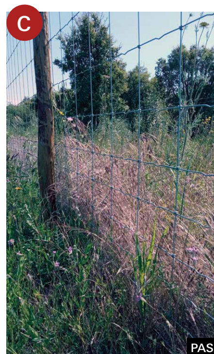
Instalação da rede em "L" nas vedações do IP2, no âmbito do projeto LIFE LINES: (A) colocação da rede em "L" junto à vedação e (B) recobrimento com terra e compactação, e (C) aspeto final da rede em "L".
