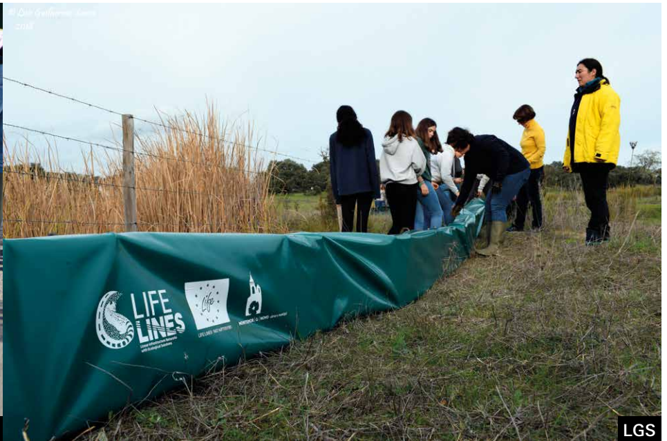
Montagem da barreira amovível em lona no projeto LIFE LINES com (A) a colocação da estrutura de suporte e estacas na lona e (B) aspeto final da barreira montada.
