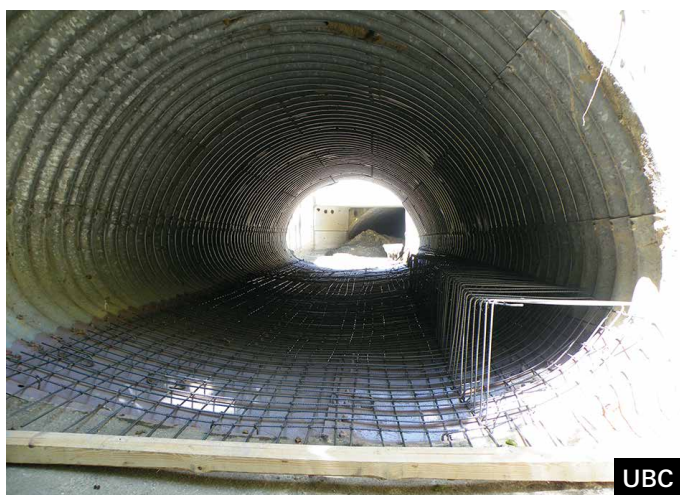
Fase de construção do passadiço e resultado final numa das PH intervencionadas.
