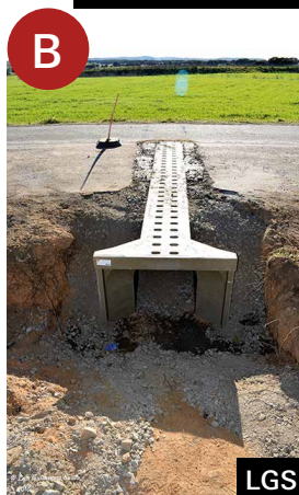
Obras de encaminhamento de fauna para a PH com recurso a barreiras permanentes em betão numa passagem intervencionada.
