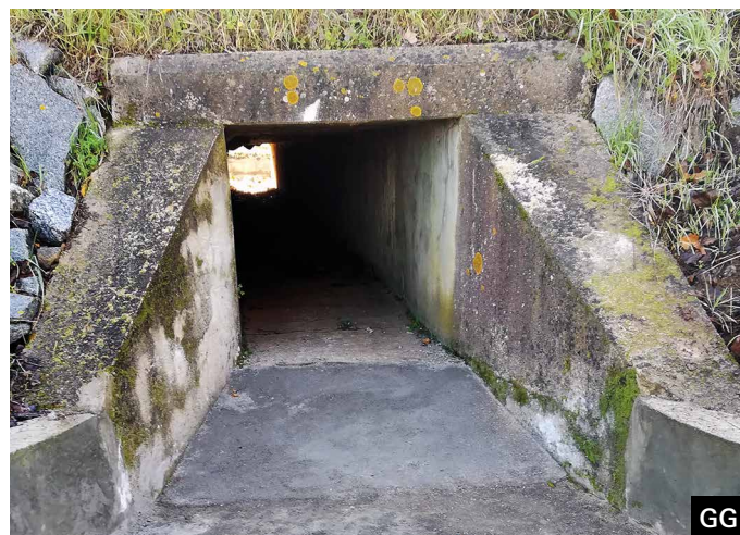
Adaptação de uma PH retangular no âmbito do projeto LIFE LINES, através do rampeamento das entradas e ligação às barreiras de encaminhamento
