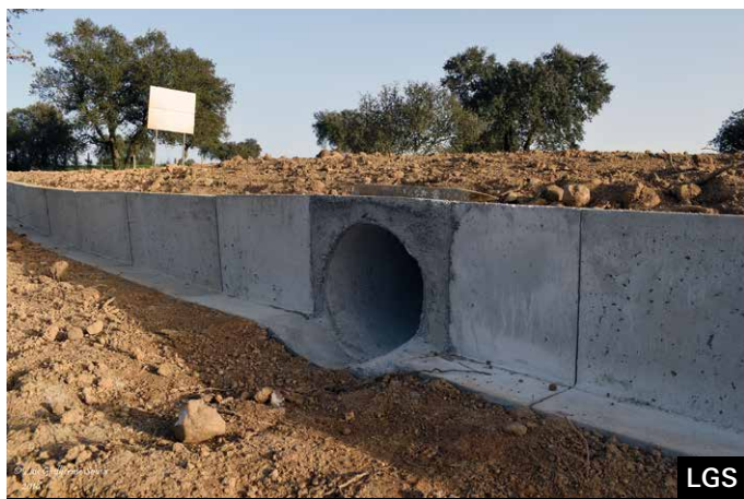
Adaptação e integração de uma PH redonda numa barreira permanente em betão.
