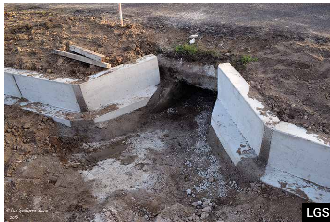
Obras de encaminhamento de fauna para a PH com recurso a barreiras permanentes em betão numa passagem intervencionada.
