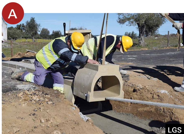
Adaptação e integração de uma PH redonda numa barreira permanente em betão.
