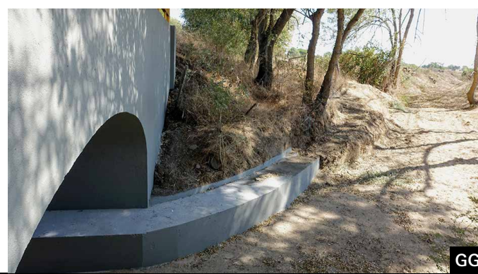
Visualização da integração do passadiço no terreno seco encaminhando os animais para o terreno adjacente numa das PH intervencionadas.
