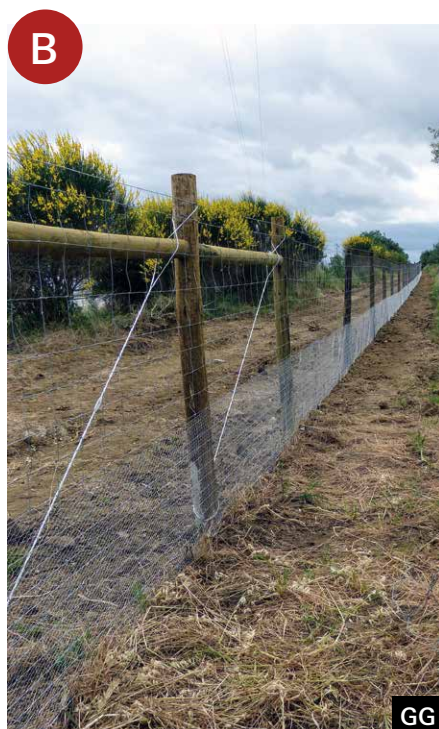
Instalação da rede em "L" nas vedações do IP2, no âmbito do projeto LIFE LINES: (A) colocação da rede em "L" junto à vedação e (B) recobrimento com terra e compactação, e (C) aspeto final da rede em "L".
