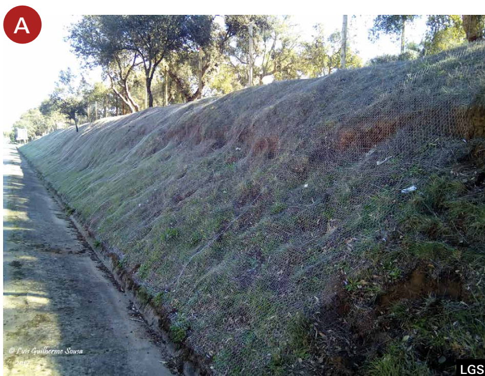
(A) Aspeto final da rede dissuasora de coelhos e (B) pormenor da colocação da rede junto às árvores para impedir locais de entrada de coelho.
