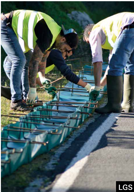
Montagem da barreira amovível em lona no projeto LIFE LINES com (A) a colocação da estrutura de suporte e estacas na lona e (B) aspeto final da barreira montada.
