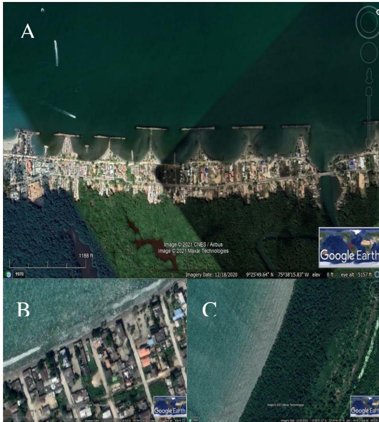
Figura 3. A) Estructuras ubicadas en la zona sur del golfo con el objetivo de mitigar la erosión costera. B) Zona de Tolu en la cual se evidencia que las construcciones se encuentran muy cerca de la línea de costa. C) Partes de la ciénaga de la Caimanera en la cual el manglar está en contacto directo con el agua salada.
