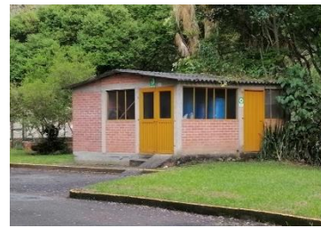
Ilustración 17: Fotografía almacén de residuos sólidos.
