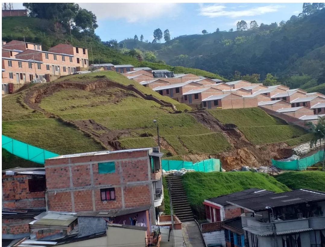
Fotografía 8. Deslizamiento en el sector de Los Pinos, cerro Monserrate. Fuente: El Diario (2019).
