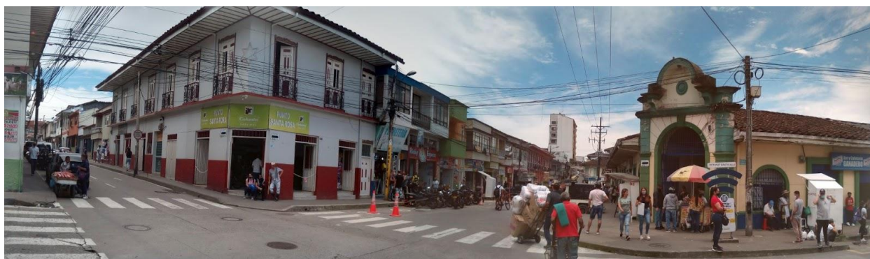
Fotografía 11. Zona centro del municipio de Santa Rosa de Cabal construida sobre llenos antrópicos.
