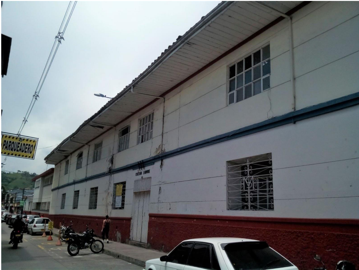
Fotografía 14. Colegio Labouré ubicado sobre llenos antrópicos.
