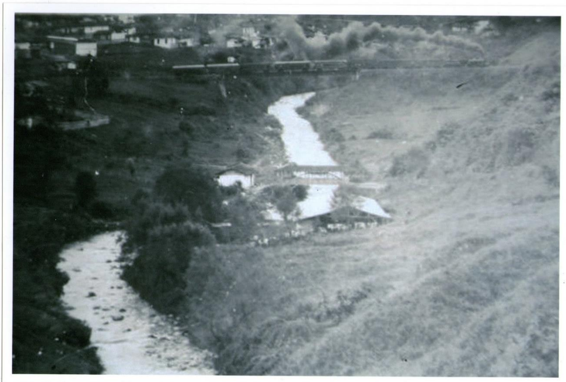
Fotografía 3. Paso del tren por el viaducto de La Hermosa cruzando el río San Eugenio en 1940. Fuente: Fernández (2013).
