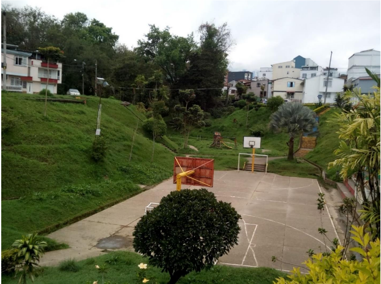
Fotografía 10. Equipamientos colectivos del barrio El Carmelo ubicados sobre llenos antrópicos construidos en la microcuenca de la quebrada La Italia.
