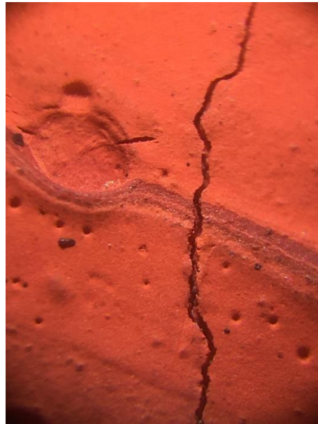
Figura 19: Registo de pormenor de fissura e textura da camada cromática Fonte: Autora
