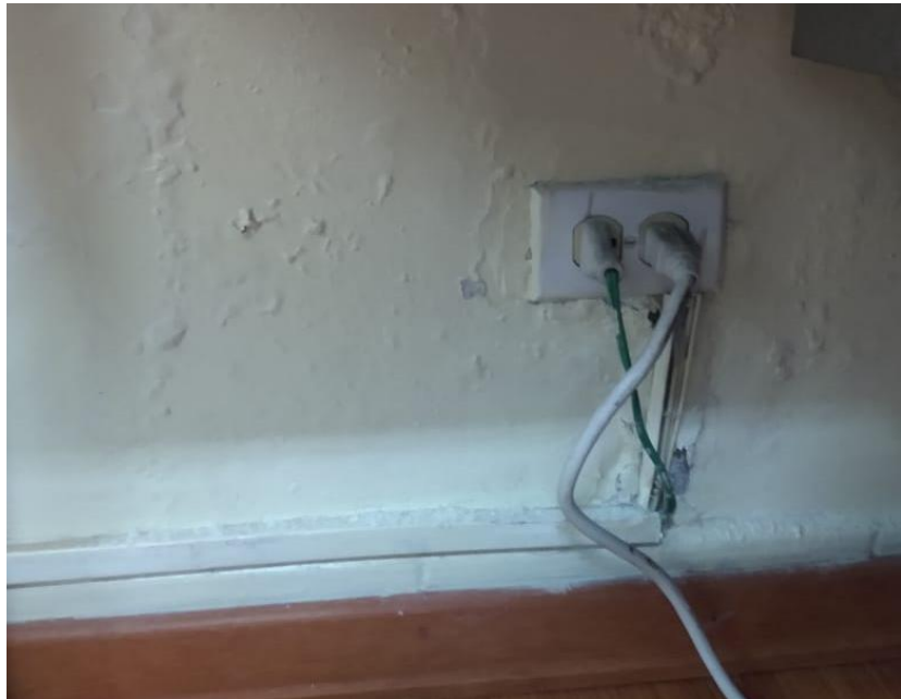
Figura 5. Circuitos improvisados. [Autor]
