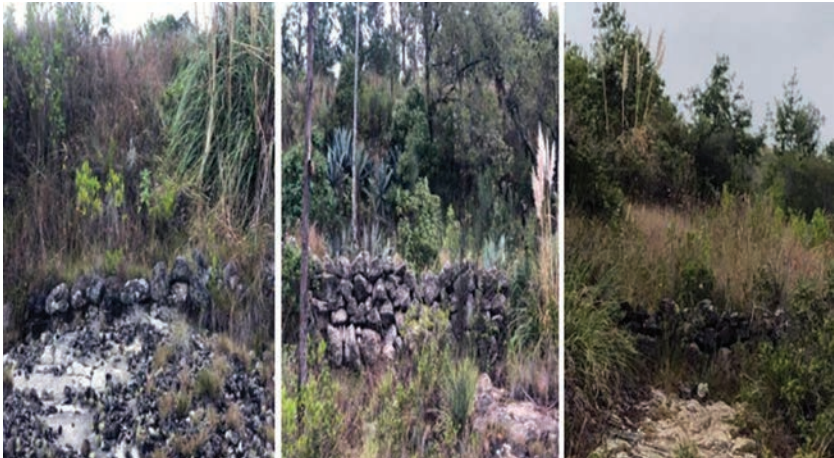
Figura 12. Muros en el sector El Plateado
