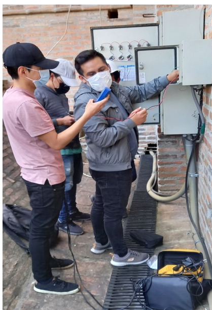
Figura 4.1: Revisión de la distribución de los circuitos de iluminación.
