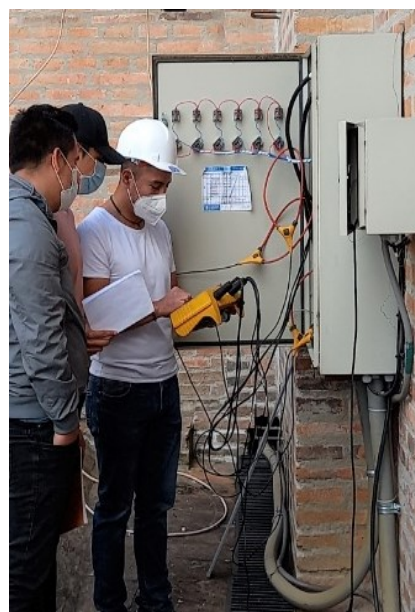
Figura 4.2: Montaje del registrador en el gabinete del cuadro de cargas.
