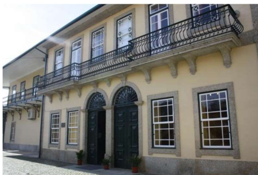
Figura 3. Fachada do Edifício Principal
