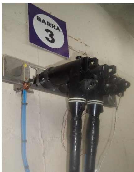
Figura 14. Conector tipo codo (COTO-EEASA-053-2020). Autor: Consorcio DG.
