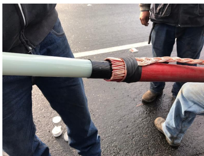
Figura 18. Tendido de cable de media tensión (COTO-EEASA-053-2020). Autor: Consorcio DG.
