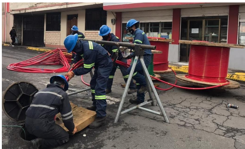
Figura 17. Tendido de cable de media tensión (COTO-EEASA-053-2020). Autor: Consorcio DG.
