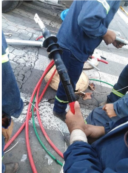
Figura 16. Conector tipo exterior (COTO-EEASA-053-2020). Autor: Consorcio DG.
