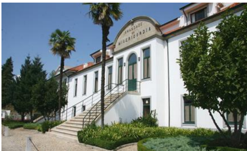
Figura 1 - Santa Casa da Misericórdia de Paredes
