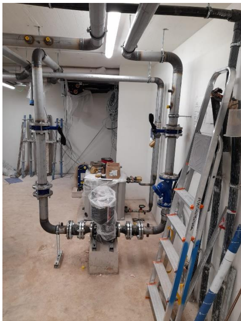
Figura 34 – Zona Técnica nas Villas
