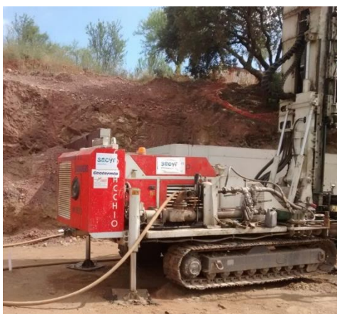
Figura 5 - Máquina utilizada nas furações
