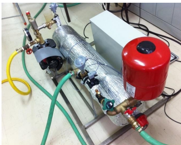
Figura 8 – Equipamento para Testes de Resposta Térmica (TRT)
