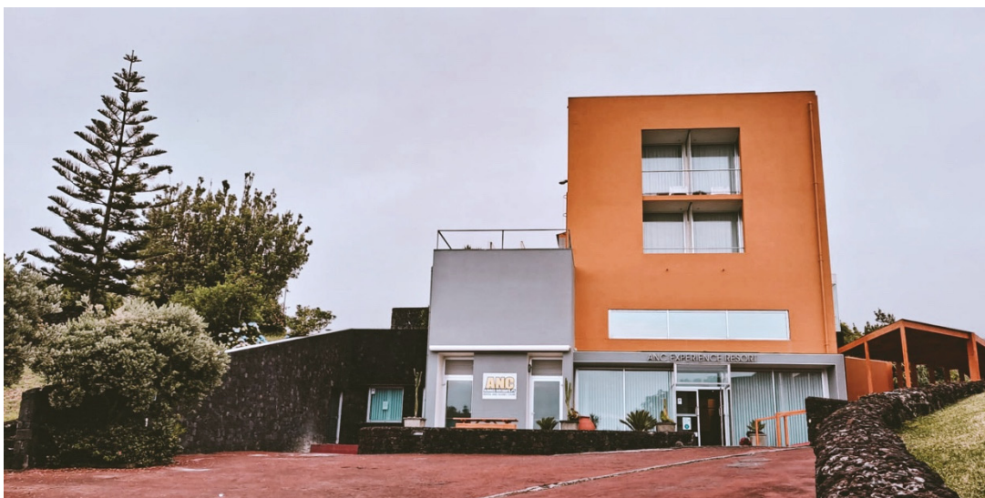
Figura 2. Vista frente do hotel.
