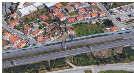
Fig. 40 - Site 4, sound barrier
