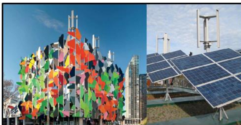
Figura 2-13: Edifício Pixel e produção de energia on site no edifício [38]
