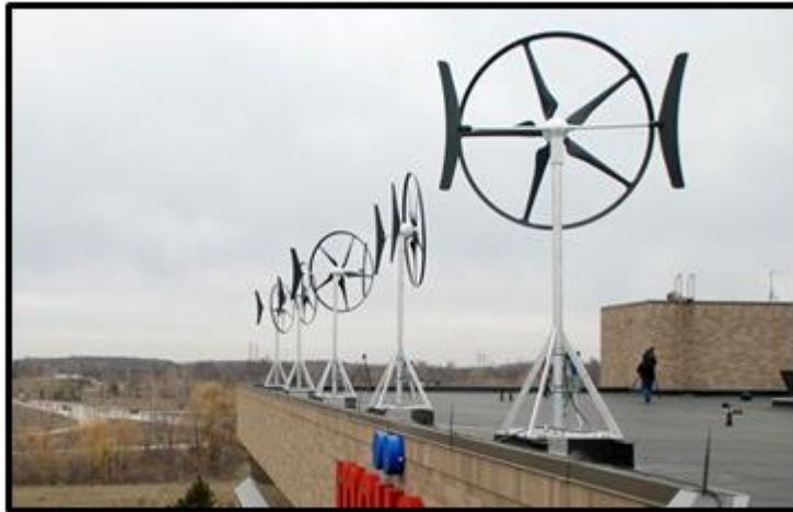
Figura 2-4: Exemplo de geradores eólicos em edifícios [14]
