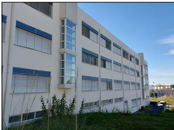
Figura 3-5: Fachada Noroeste da residência dos estudantes do IPV
