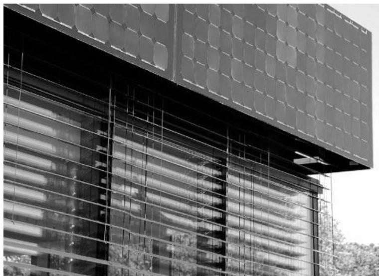
Figura 2-18: Sistema de sombreamento externo [23]
