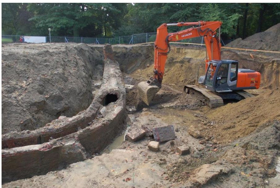
Figuur 4: De aanwezige graafmachine voerde enkele bijkomende graafwerken uit om de archeologische resten beter te kunnen bestuderen (© agentschap Onroerend Erfgoed).
