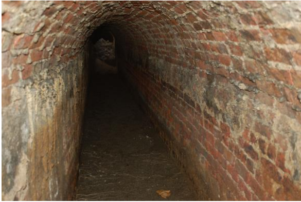
Figuur 10: Binnen aanzicht van het toegankelijke deel van de Brouwersbuis (© agentschap Onroerend Erfgoed).
