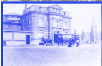
Afbeelding 17: oorspronkelijke hoofdingang zwembad
