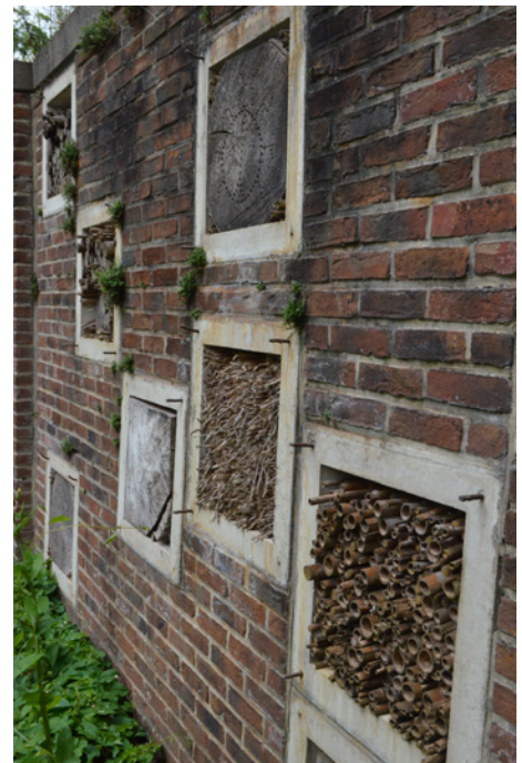
Een ongebruikt columbarium kan perfect dienstdoen als insectenhotel. Deze nog ondergewaardeerde vorm van erfgoed krijgt zo alvast een nieuwe functie. Leuven, Centrale begraafplaats. Copyright Onroerend Erfgoed
