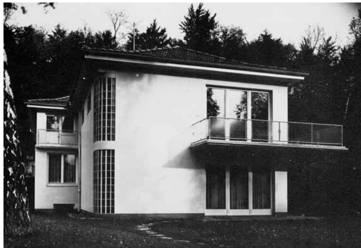
111. Lucy Hillebrand, Wohnhaus Helmuth Plessner (1892–1985), 1952, Göttingen, Herzberger Landstraße 97, heute stark umgebaut
