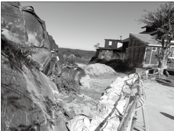
写真2 台風19号による土砂崩れの現場 （筆者撮影 2019.10.28.）
