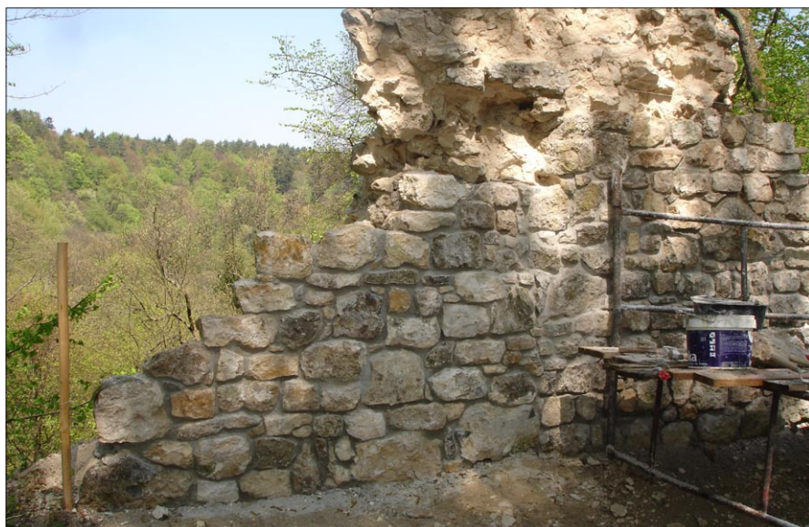
Ryc. 4. Fragment muru obronnego od strony północnej podczas prac naprawczych w 2006 r. Fot. M. Bicz-Suknarowska
