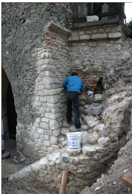
Ryc. 7. Widok bramy od strony dziedzińca w trakcie prac w 2006 r., na pierwszym planie rekonstrukcja schodów kamiennych z ryc. 5. Fot. M. Wojenka
