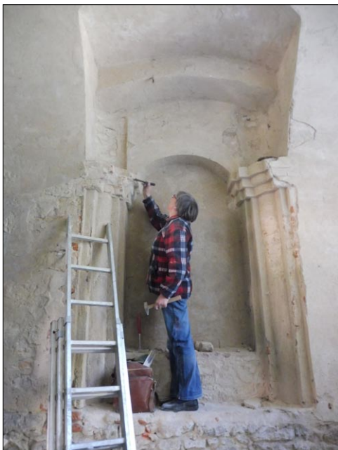
Ryc. 11. Prace przy wnęcie wewnątrz parteru bramy. Fot. Andrzej Weber
