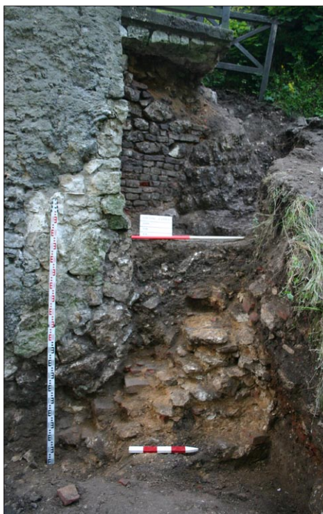
Ryc. 5. Relikt nowożytnych schodów prowadzących do pomieszczenia na piętrze bramy, ujawniony podczas prac w 2006 r. Fot. M. Wojenka
