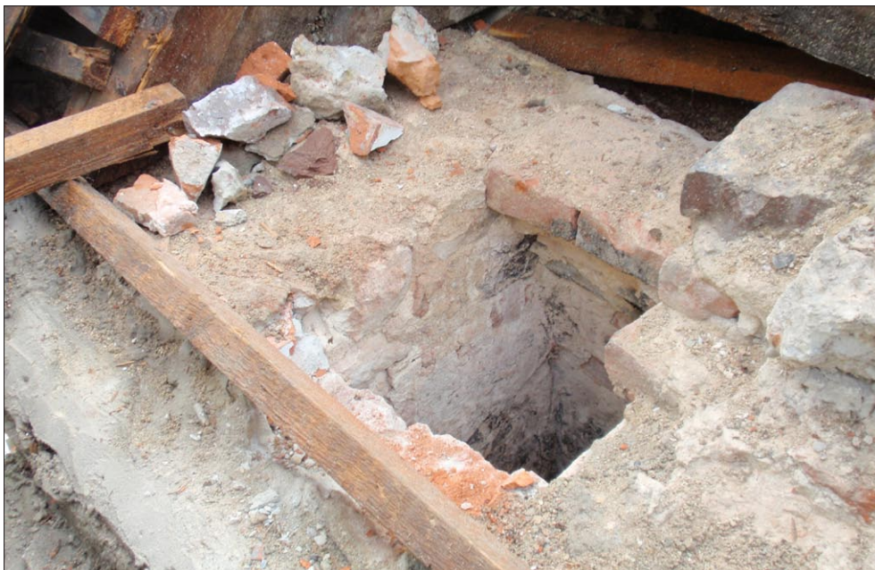
Ryc. 15. Wnętrze dawnego komina odsłonięte podczas prac przy dachu bramy. Fot. M. Bicz-Suknarowska
