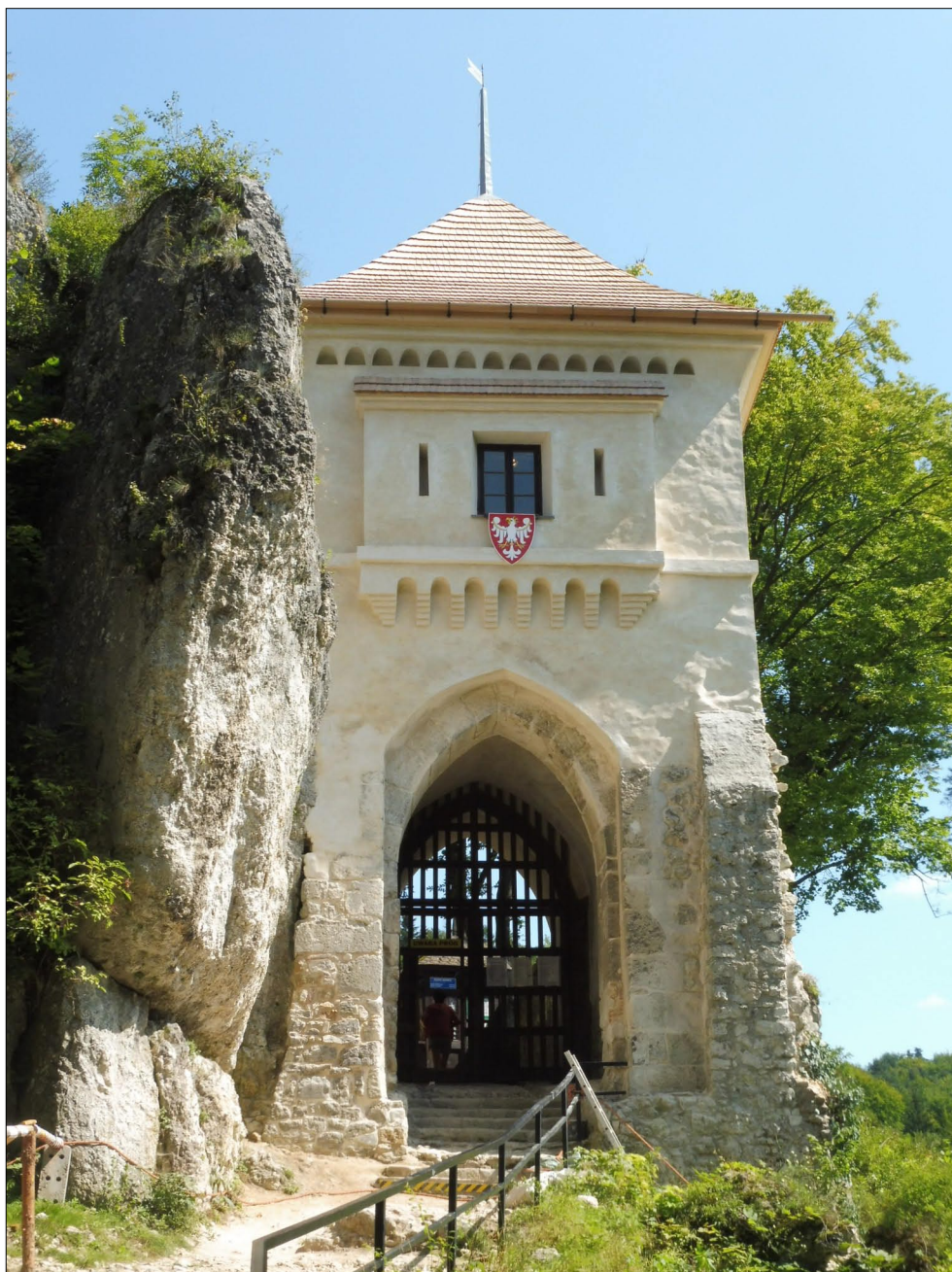
Ryc. 13. Budynek bramy od zachodu (od zewnątrz), widok po zakończeniu prac. Fot. z archiwum Ojcowskiego Parku Narodowego
