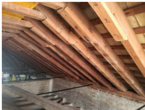
Fig. 1.34_Egiones en la unión par-nudillo
