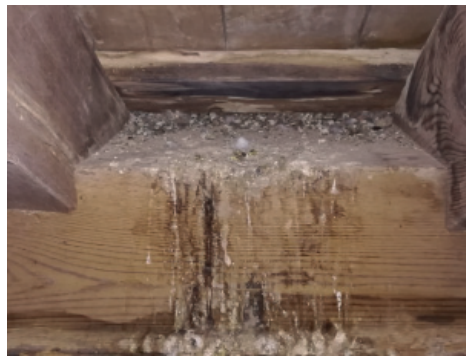
Fig. 1.68_Numerosos depósitos de suciedad
