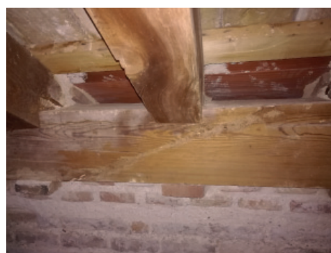
Fig. 1.42_Par original, frente a estribo, correa y rasilla nueva
