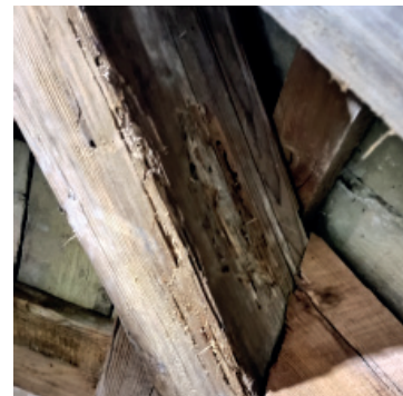
Fig. 1.69_Ataque inactivo de termitas
