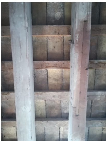
Fig.1.137_Pieza más nueva frente a otra reutilizada
