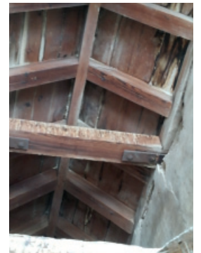
Fig. 1.54_Techumbre de mansarda
