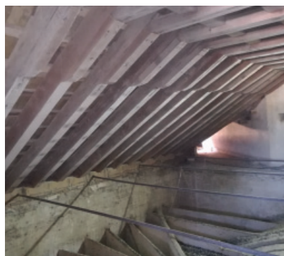
Fig. 1.52_Aspecto del camaranchon EV4
