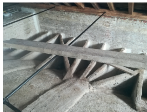
Fig. 1.33_Arriostramiento de bóveda encamonada
