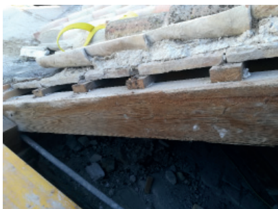
Fig. 1.114_Sección y composición de la tablazón
