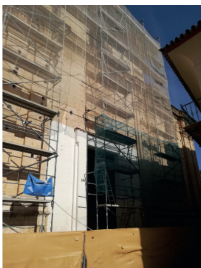
Fig. 1.24_Andamios de ascenso a cubiertas
