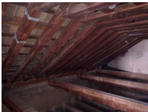
Fig. 1.29_Armadura en EP4
