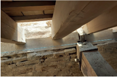
Fig.1.141_Aplastamiento del estribado tras haber sobrepasado el punto límite de reducción de sección debido a la pudrición [1]
