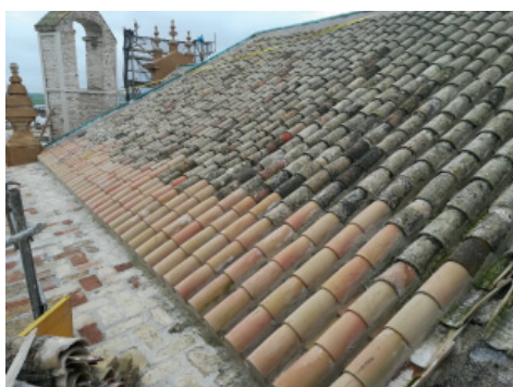
Fig. 1.64_Levantamiento y sustitución del estribado
