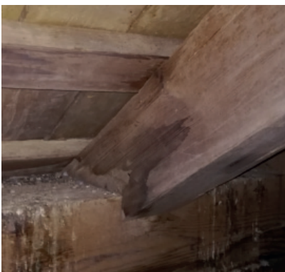
Fig. 1.118_Alto contenido de humedad en entrega de algunos pares
