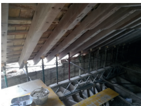
Fig. 1.104_Apeo de paño de cubierta para sustitución de estribado por bataches
