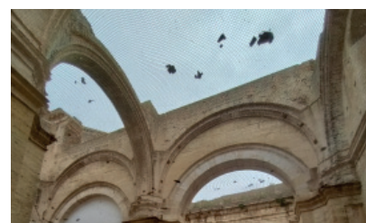
Fig. 1.18_ Malla de seguridad sobre la entrada
