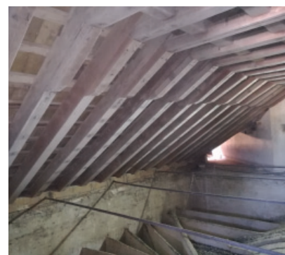
Fig. 1.39_Tirantes metálicos, solo transversales
