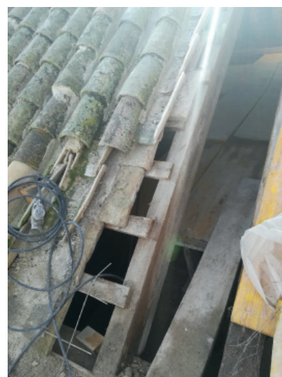
Fig. 1.92_Apertura de huecos durante la reparación del sector C5-AM
