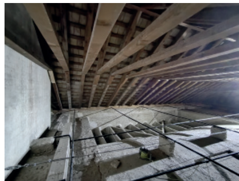
Fig. 1.35_Sistema de tirantes metálicos, dos longitudinales
