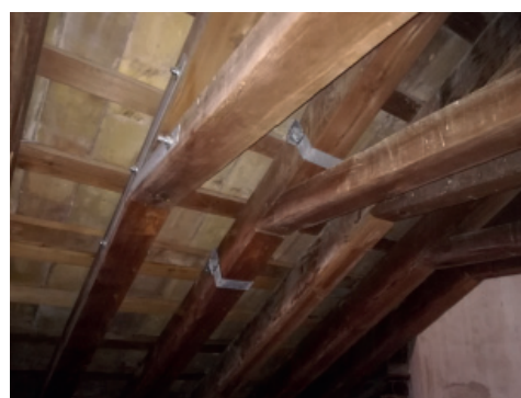
Fig. 1.44_Nuevos herrajes de acero en pares originales
