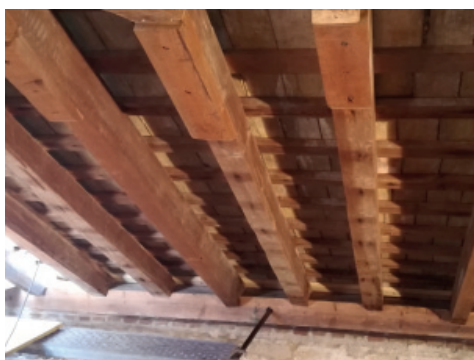
Fig. 1.47_Aspecto de las maderas y tablazón
