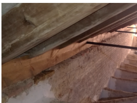
Fig. 1.66_Considerable deformación de los estribos
