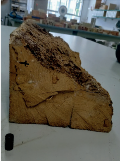
Fig. 1.117_Pérdida aproximada del 50% de la sección en estribos
