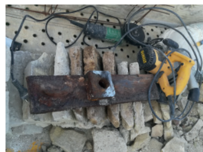
Fig. 1.134_Chapa de fijación de tirantes
