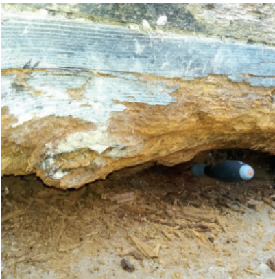
Fig. 1.95_Cara oculta de los estribos
