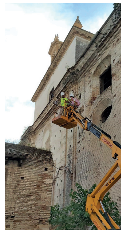
Fig. 1.106_Inspección de sectores no accesibles
