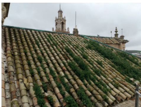
Fig. 1.37_Exterior de sector EV4
