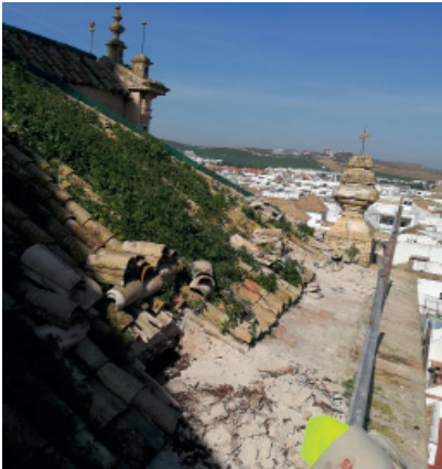
Fig. 1.94_Apertura de catas para examinar estribos
