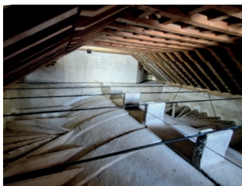
Fig. 1.38_Caranchón de cubierta EV4
