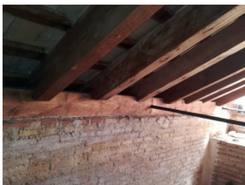
Fig. 1.46_ Estribo nuevo bajo pares originales
