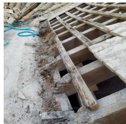
Fig. 1.58_Estribo de EP4 antes de la reparación
