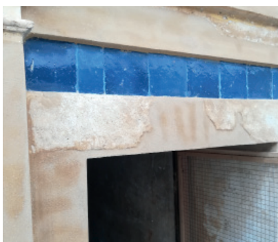
Fig. 1.101_Pruebas sobre acabados finales
