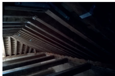
Fig. 1.62_Leve pandeo del plano de cubierta
