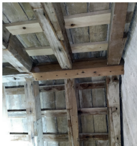
Fig.1.49_Ensamblado de pares antiguos con pernos
