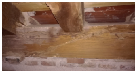
Fig. 1.61_Nueva separación del estribo con el fondo
