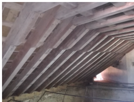
Fig. 1.70_No se aprecia deformaciones en los paños
