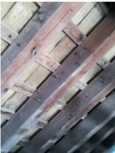
Fig. 1.56_Uniones en cabeza de pares
