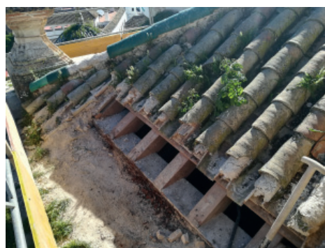
Fig. 1.102_Apertura de catas en estribado
