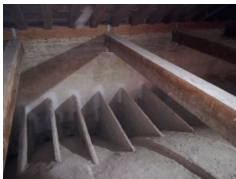
Fig. 1.28_Arriostamiento de bóveda encamonada
