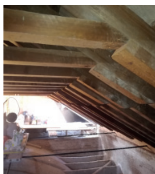
Fig. 1.67_Pandeo del plano de cubierta
