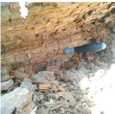
Fig. 1.96_La madera ha perdido todas sus propiedades
