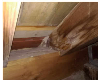
Fig. 1.91_Humedad en cabeza de par. EP4
