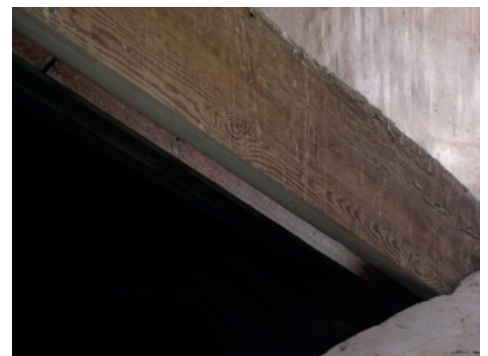
Fig. 1.71_Se aprecia una disminución de densidad superficial
