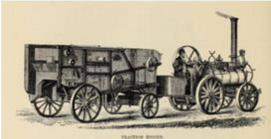
Figura 37. Trilladora enganchada a un motor de tracción (1862) [47]
