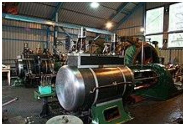
Figura 43. Motor de bobinado conservado en Papplewick Pumping Station [47]
