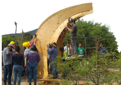
Fig. 15: Montaje Cactus Pavilion. Fuente: autor.
