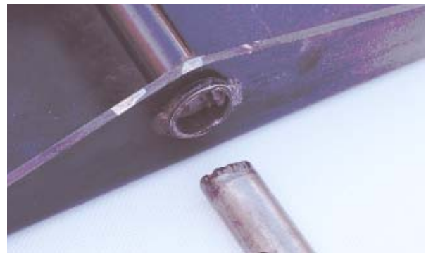
Figura 4. Eje de soporte basculante roto en la unión a la chapa soporte.
