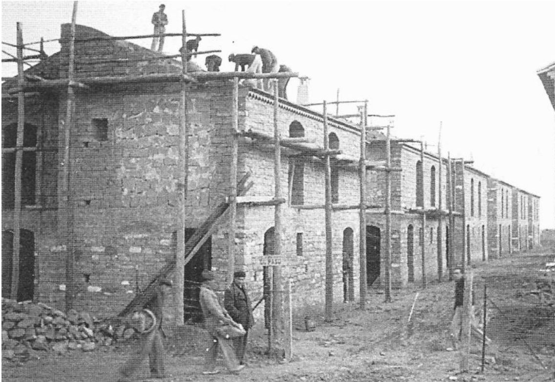
Imagen 4: Proceso de construcción de las viviendas. En la imagen se puede observar la fábrica de piedra sentada sobre hiladas de barro y arcos de descarga para la ubicación de ventanas. Fuente: Antonio Recuerda Burgos, cronista de la ciudad.
