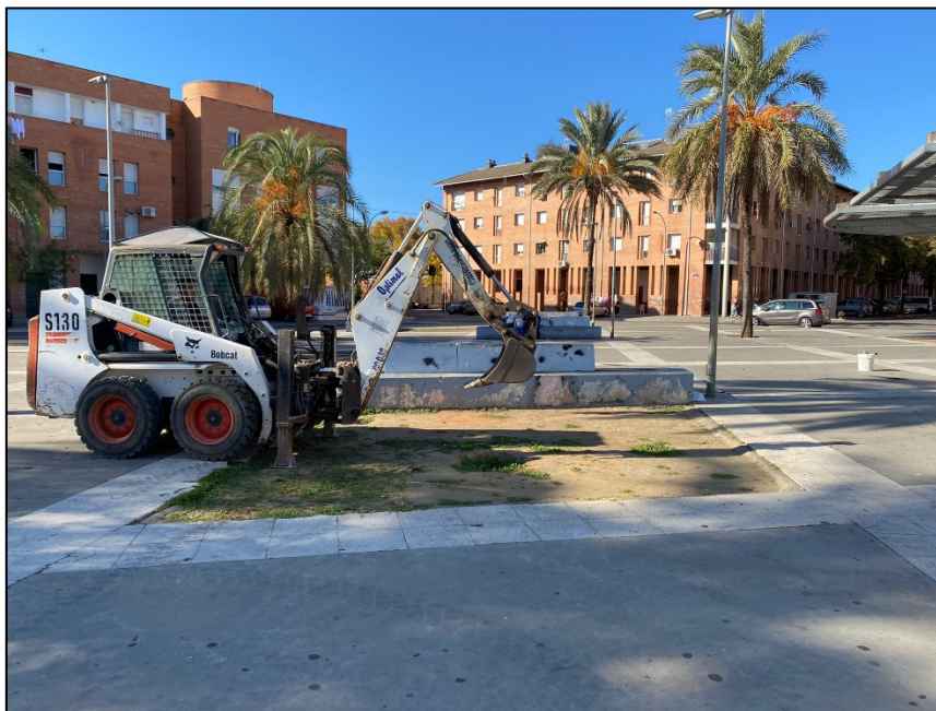
Ilustración 43. Fotografía de la maquinaria usada en la actuación. Fuente: GrupoTAR.
