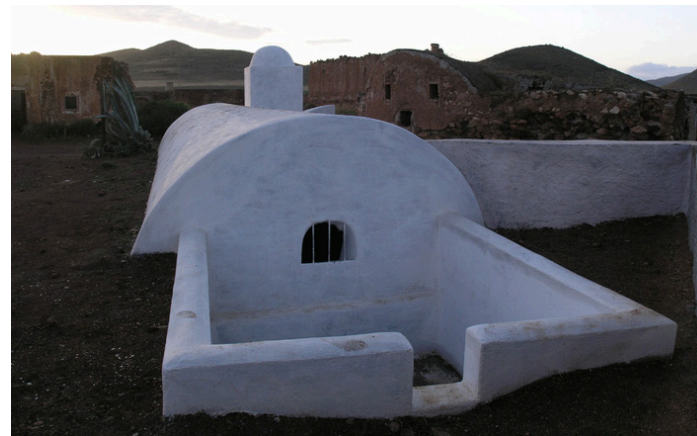
Fig. 6. Aljibe de riego en el Cortijo del Fraile. Fuente: Carta de Baeza
