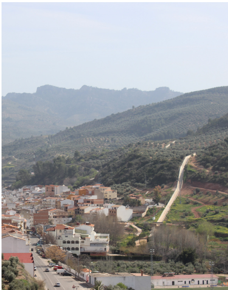
Fig. 71, 72 y 73. Canal de Valparaíso, estado actual. Fuente: elaboración propia
