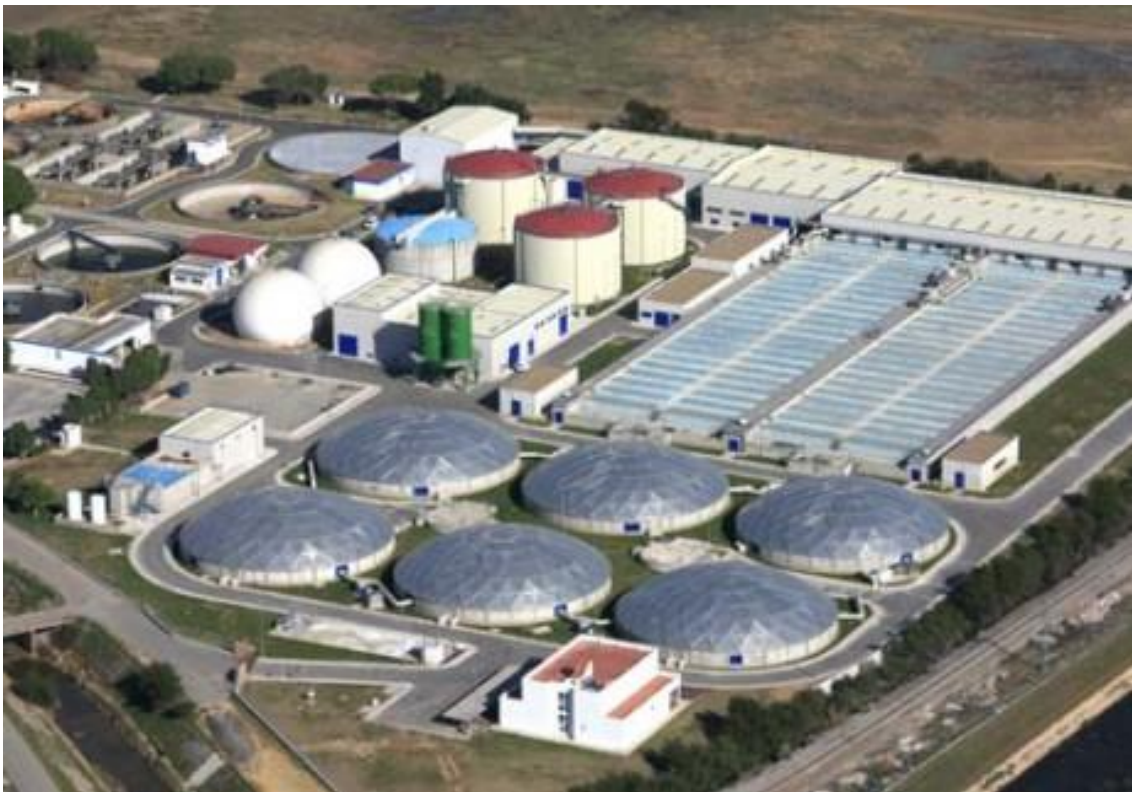
Figura 1-8 Estación Depuradora de Agua Residuales Ranilla (EDAR Ranilla – Emasesa, 2021)
