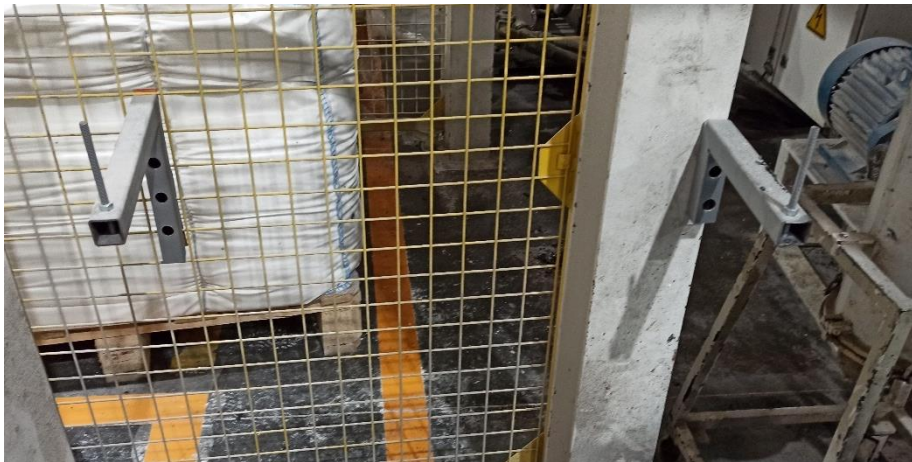
Figura 8 - Suporte para a tubagem
