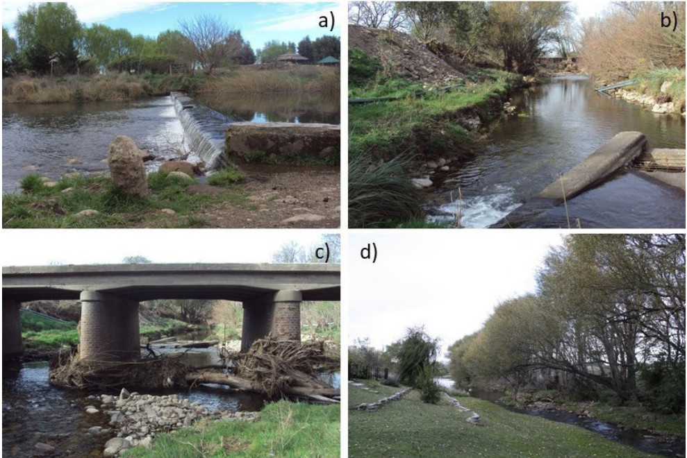
Fig. 3 – Intervenciones antropogénicas en la cuenca baja, a) dique transversal al curso principal, b) y c) elementos antrópicos (escombros) y restos de vegetación, d) uso de suelo para residencia. Figura en color disponible en línea.
