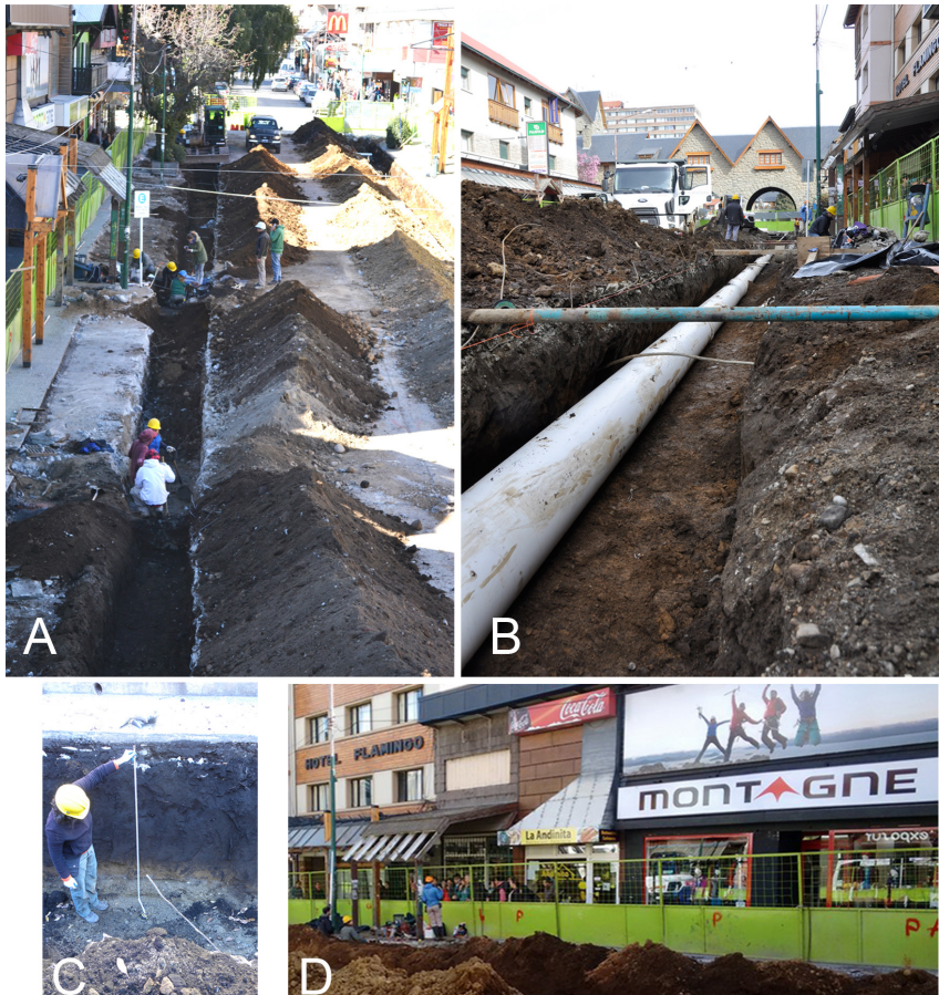
Figura 3. Vista de los trabajos de seguimiento de obra de calle Mitre. A y B) trinchera en Mitre al 0/100; C) relevamiento de estratigrafía natural (Mitre 200); D) actividades de difusión con la comunidad local durante las excavaciones (Mitre 50).
