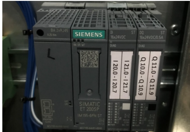
Slika 8.9: Siemens ET 200SP kartica s 16 DI/DO
