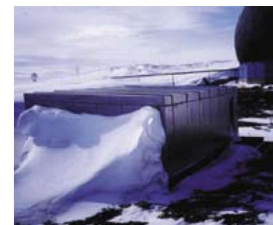
昭和基地の新地震計室(手前)と衛星受信大型アンテナ(奥)
