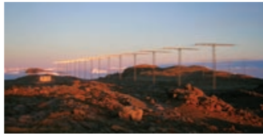
第2レーダー全景:奥の4本が干渉計アンテナ列
